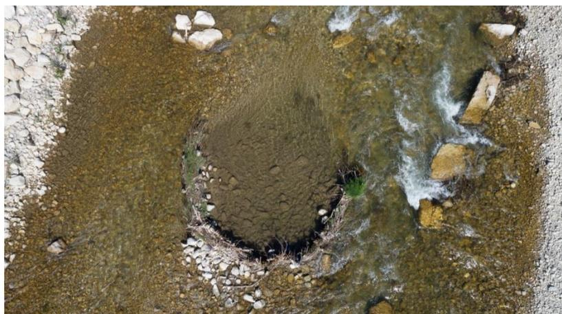
Diversification locale des écoulements au moyen de blocs et d'épis en fascine de saules.
