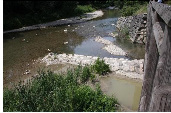
Banc alluvial à l'amont immédiat du pont du Tremblay (à gauche), dépôt et bancs alluviaux à l'entrée du bras de décharge de Technolac (à droite).
