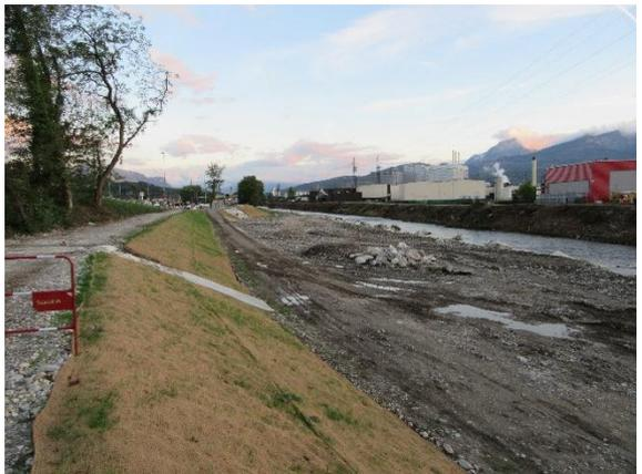
A gauche : Mise en place de la terre végétale sur les matelas Réno ; à droite : protection des terres végétales par des toiles coco.
