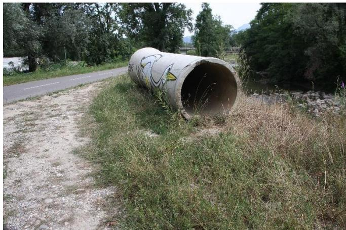
A gauche : travaux sur le réseau d'assainissement en septembre 2015 aux alentours du PKL4.2. A droite : buse béton  $\varnothing 1200$  déposée dans le cadre des tranches de travaux précédentes.
