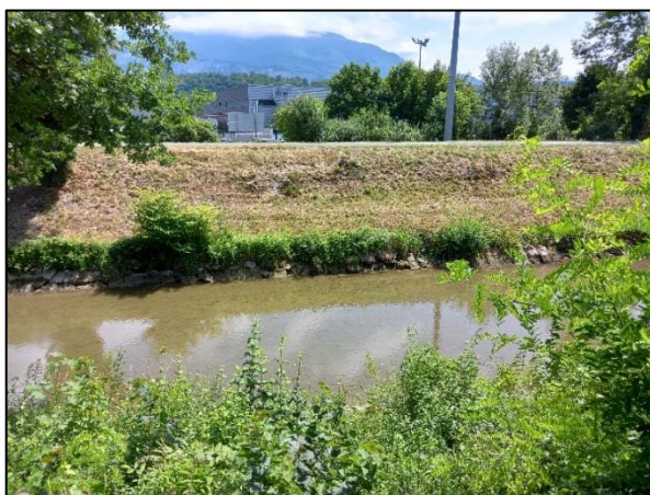
Photo 3 : Talus amont vers le PKL 5.4
