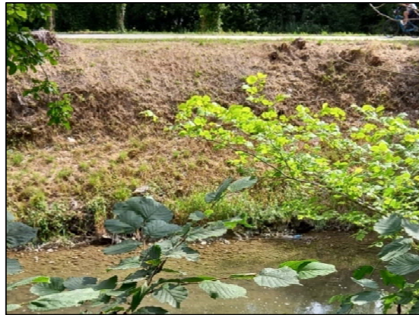
Photo 2 : Talus amont vers le PKL 4.8
