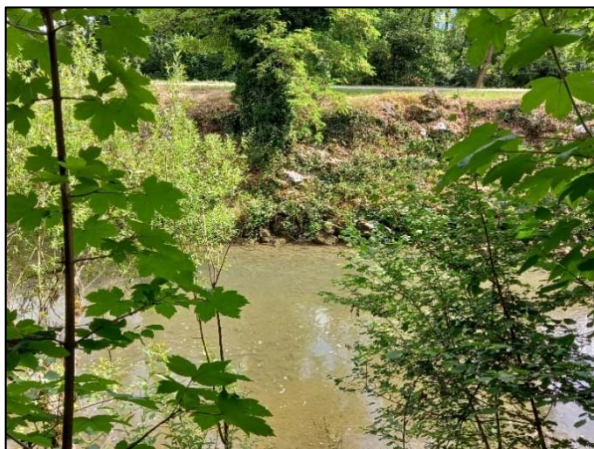
Photo 1 : Talus amont vers le PKL 4.8
