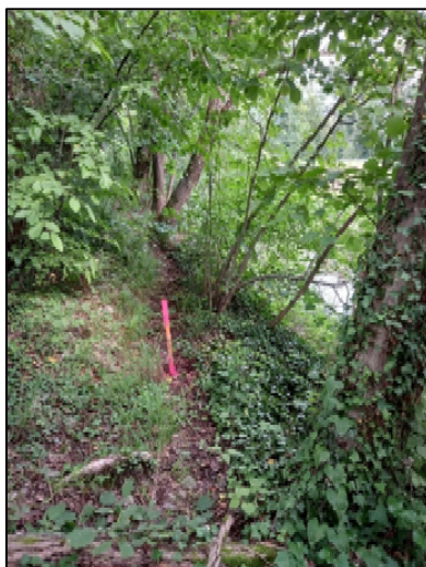
Photo 5 : Crête de la digue au point de sondage SC11
