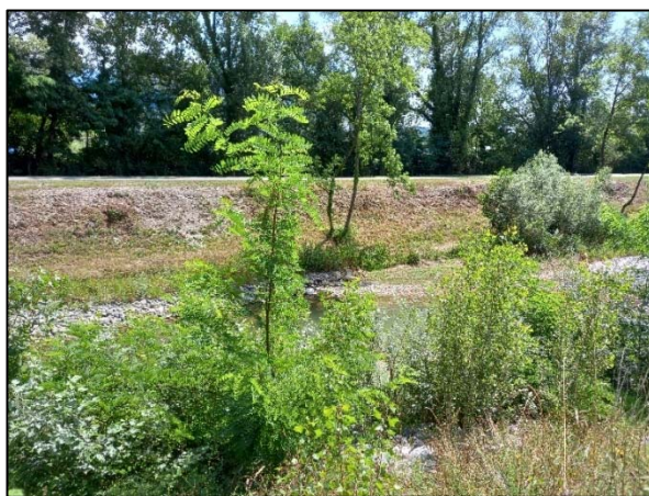
Photo 4 : Talus amont vers le PKL 5.5
