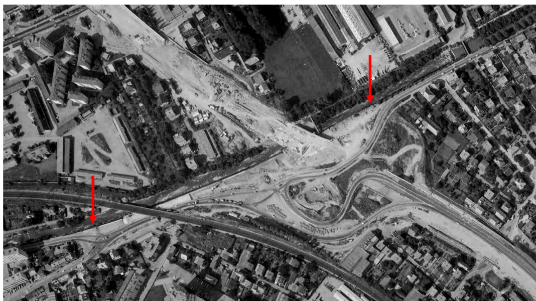
Figure 14 – Vue aérienne du chantier de la VRU en 1980 ( www.geoportail.gouv.fr ) (Flèches rouges : limites amont et aval approximatives des palplanches)
