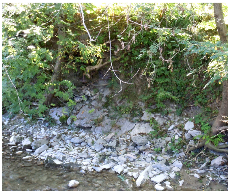
Figure 14 - Eléments du perré de la digue 4.1 (photo sept. 2014, ACTHYS)
