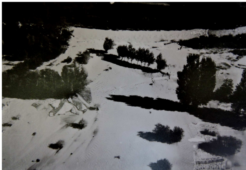
Figure 8 – Brèche dans une digue de Bissy, 1960 (AD 73 – 3Fi 1519)
