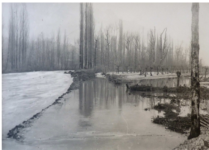
Figure 3 - Brèche dans une digue de la Lysse en mars 1914 (AD 73 – S 1295)
