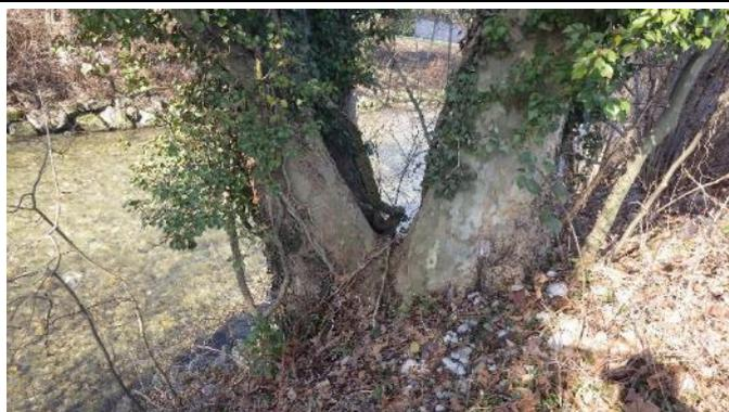
Photo 26 : Gros platane risquant de détruire le talus de l'ouvrage
