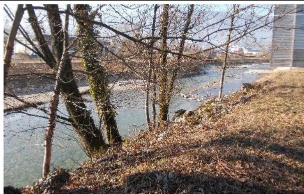
Photo 2 : Vue des arbres penchés implantés dans les enrochements du talus côté rivière
