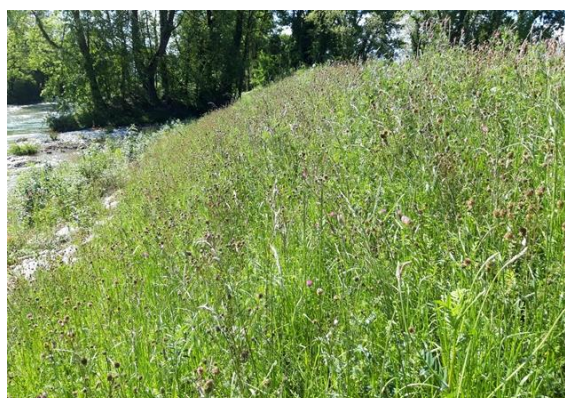
Photo 1 : Talus de digue enherbé sur un tronçon de Leyse réaménagé à Chambéry (source : CNR/SAFEGE)
