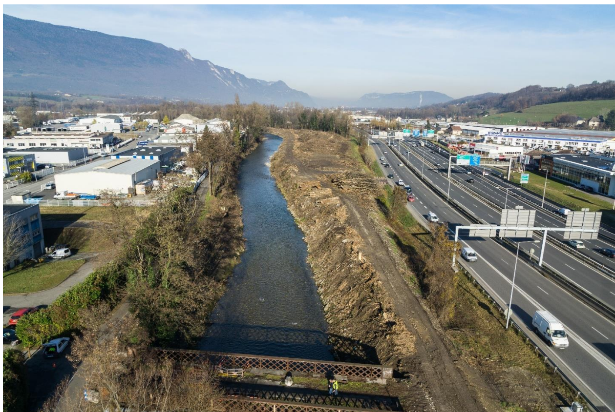
Photo 35 : Décembre 2015, démarrage du chantier/défrichements (CISLAB)
