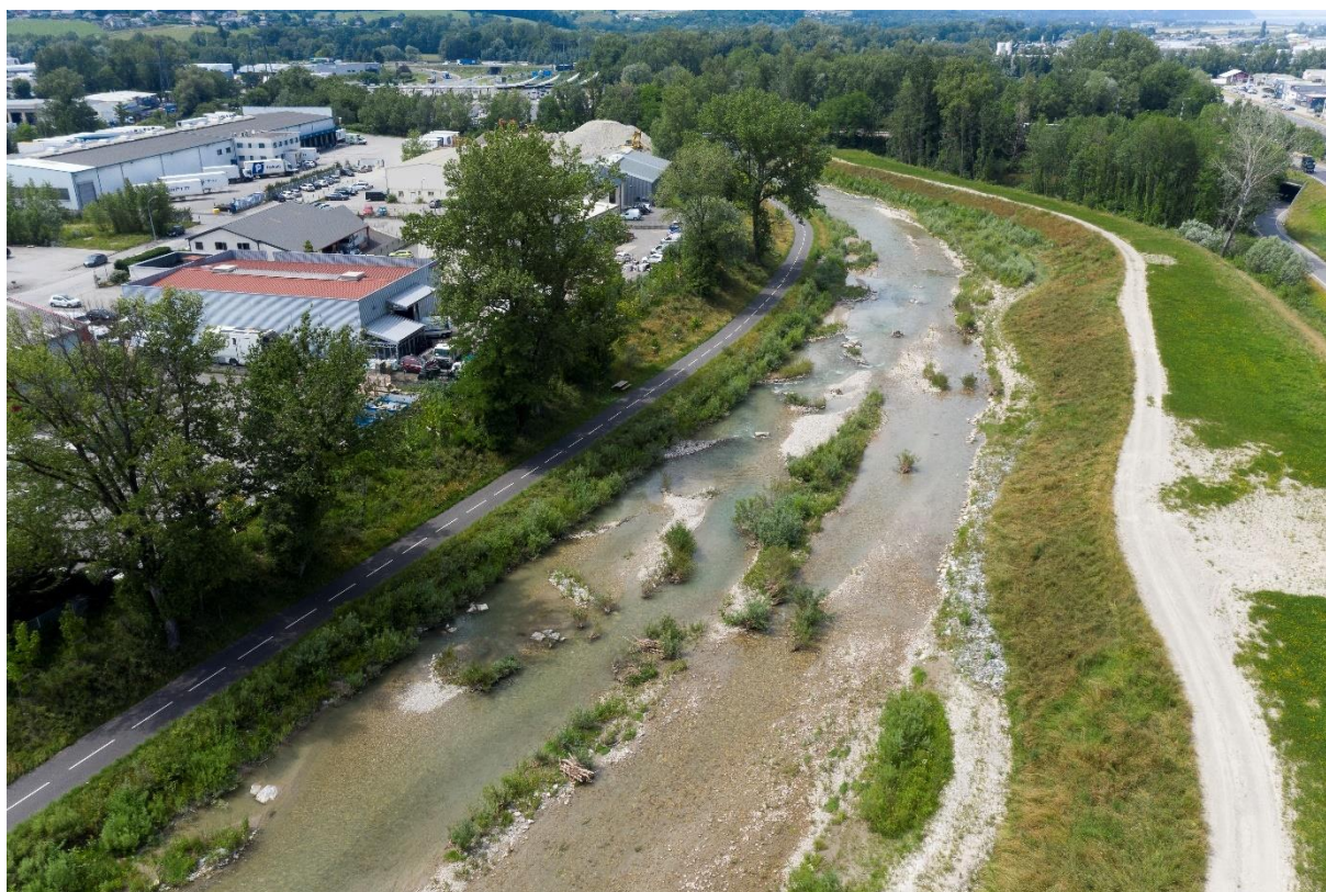
Photo 38 : Juin 2019, 1 an après la fin de chantier (CISALB)
