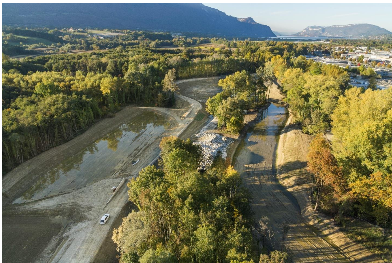
Photo 41 : Terrassements en cours de chantier, octobre 2016 (CISALB)
