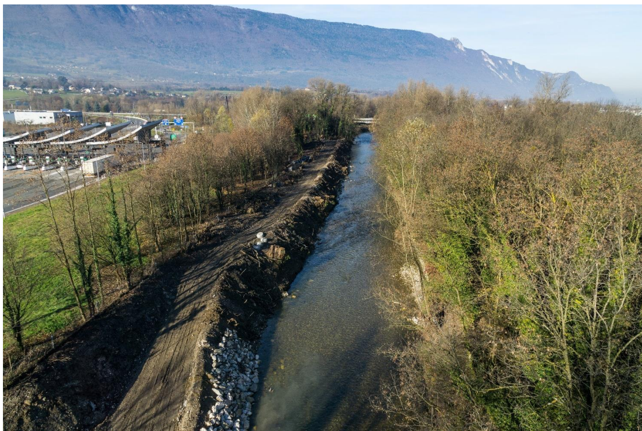
Photo 39 : Décembre 2015, démarrage du chantier (CISLAB)
