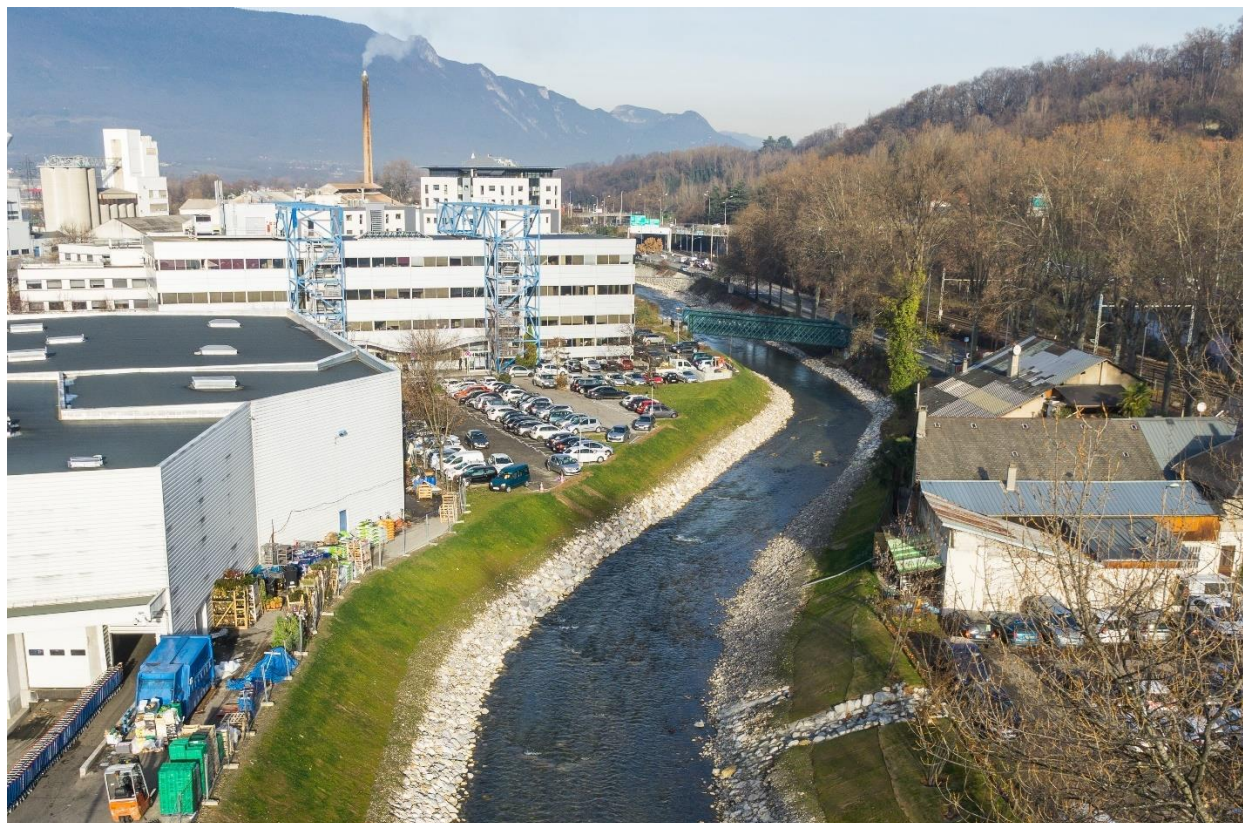
Photo 23: Fin de chantier avant revégétalisation (CISALB)
