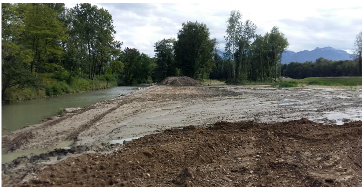
Photo 43: 2017, terrassements en cours pour renaturation d'une zone humide sur Pré Marquis (CISALB)
