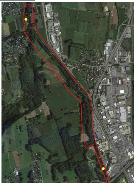
TRAVAUX DE REPRISE DES DIGUES DE LA LEYSSE AVAL L'aval de la digue de la Leysse
