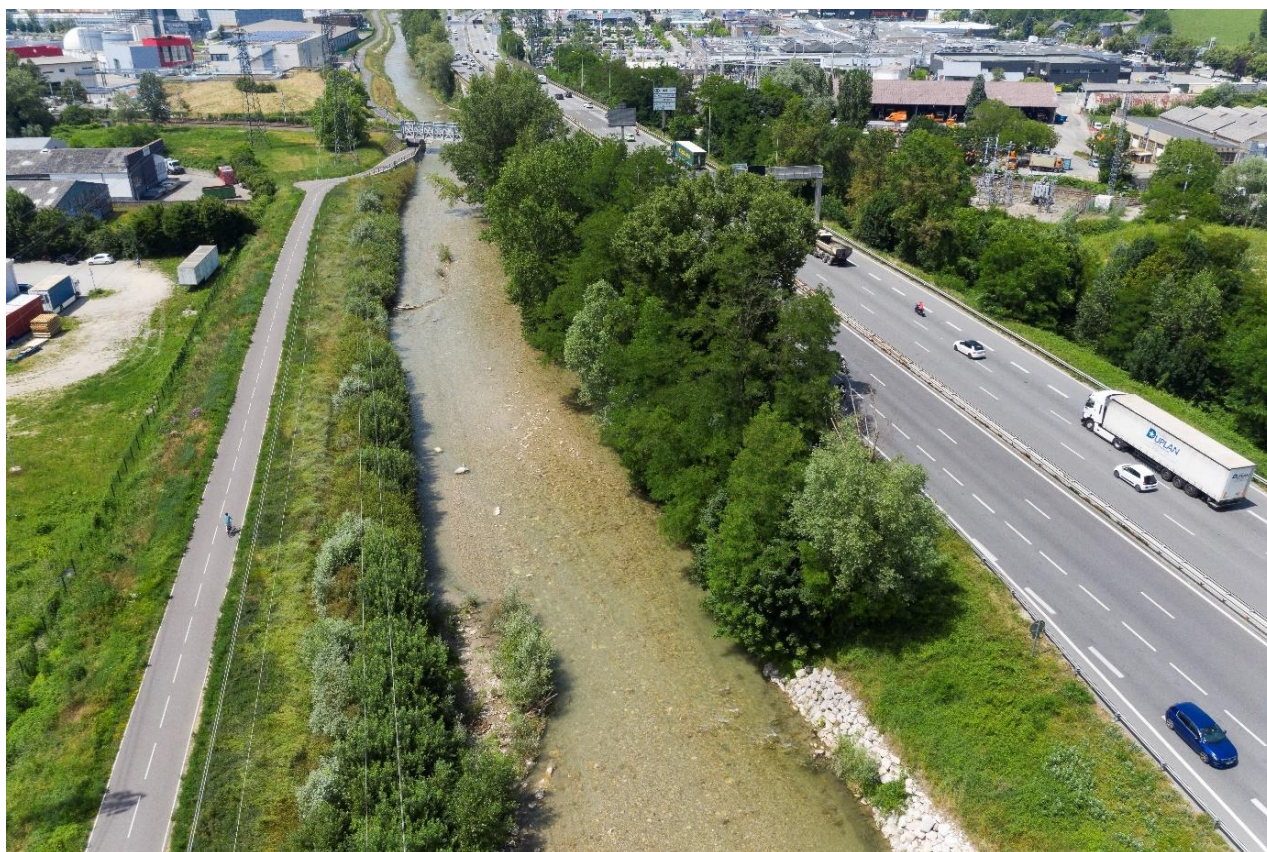
Photo 30: Juin 2019, 3 ans après la fin du chantier (CISALB)
