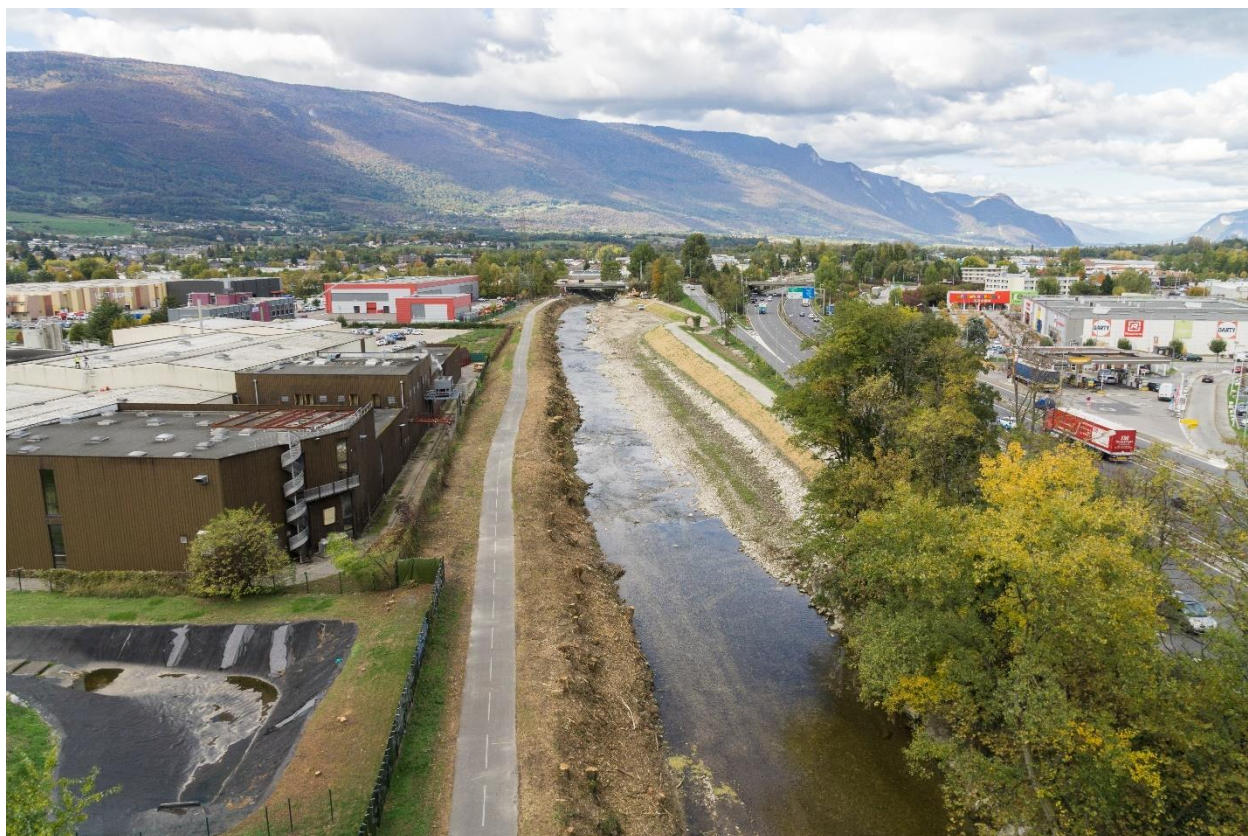
Photo 31 : Octobre 2016, fin de chantier rive droite, avant intervention rive gauche (CISALB)
