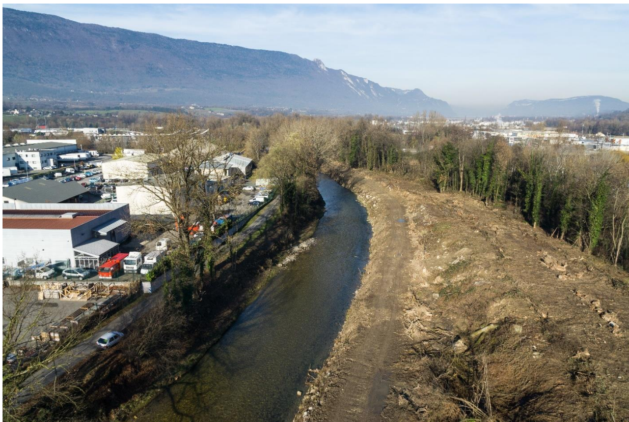
Photo 37 : Décembre 2015, démarrage du chantier/défrichements (CISALB)
