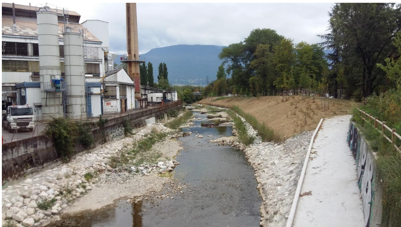
Photo 27: Septembre 2016, 1 an après la fin de chantier et revégétalisation (CISALB)
