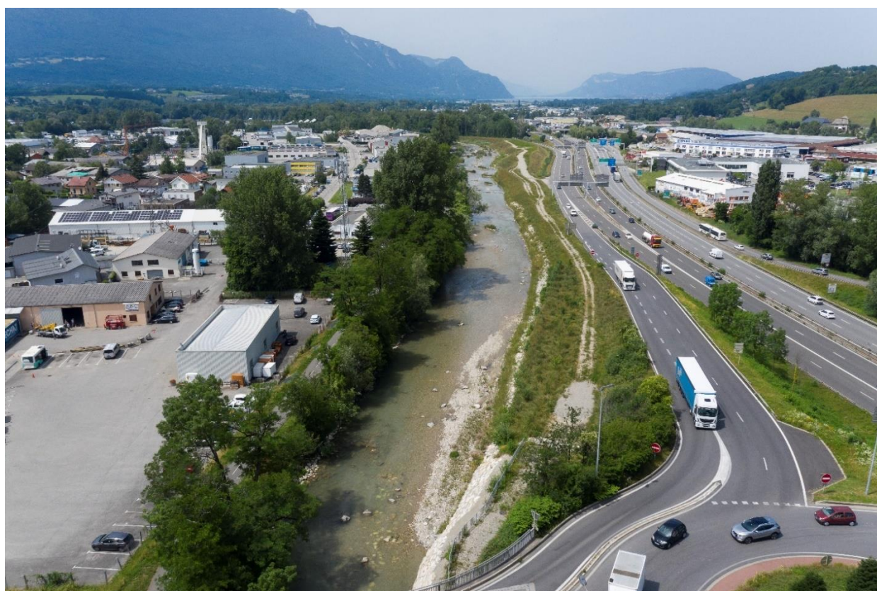
Photo 34 : Juin 2019, 1 ans après la fin de chantier (CISALB)
