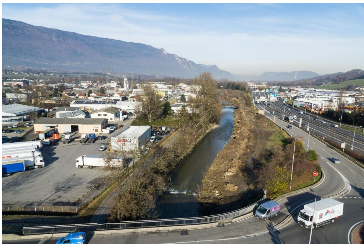
Photo 33 : Décembre 2015, démarrage du chantier/défrichements (CISALB)
