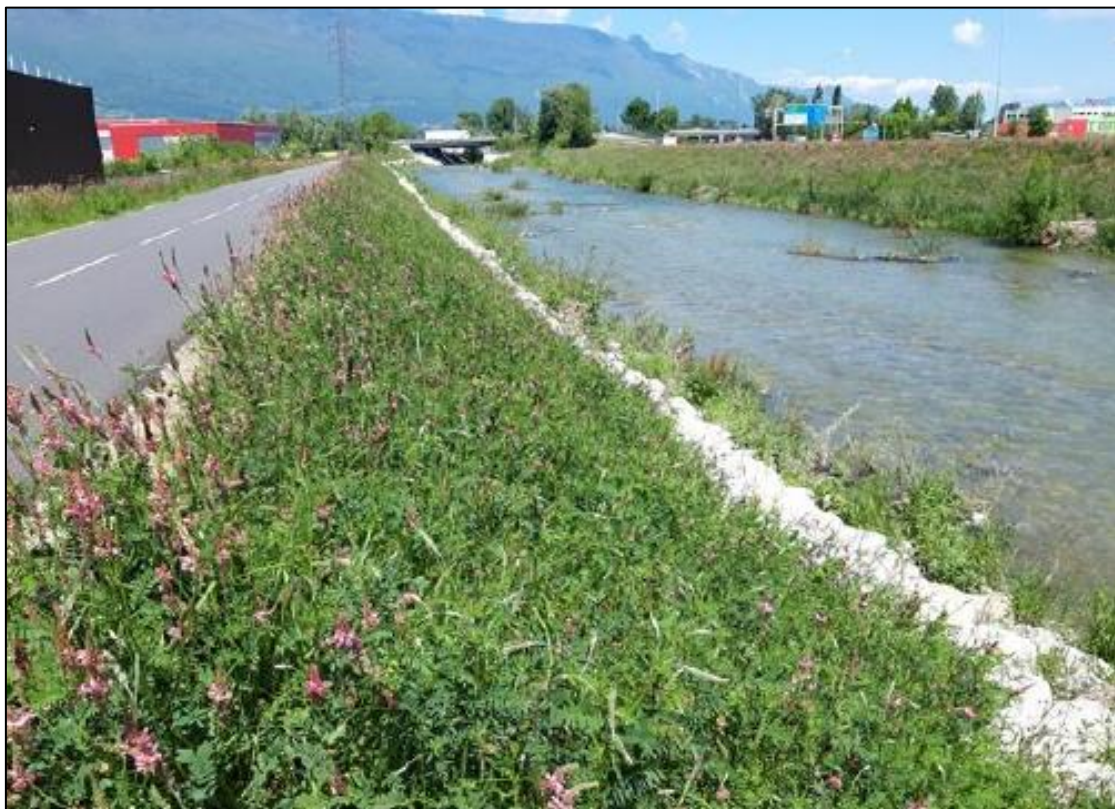
Figure 45 - Intégration des parements de digue (N+2)
