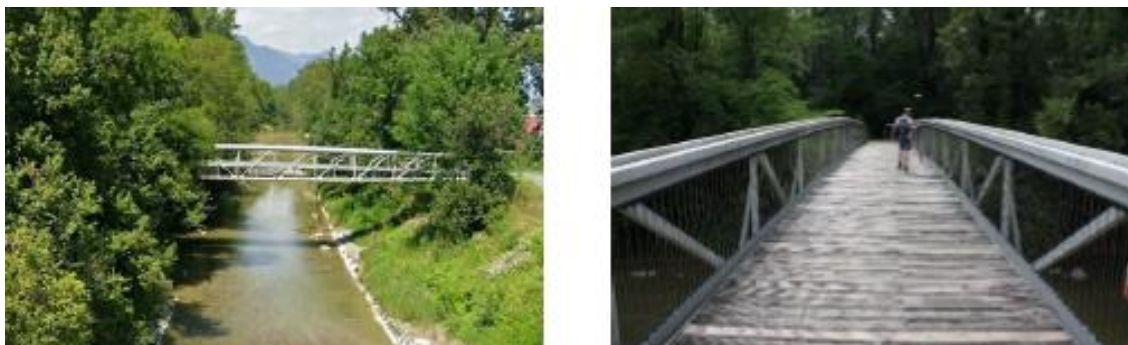
Figure 7: Passerelle de Pré Marquis vue du pont de l'Autoroute (à gauche, source : Google Earth) et vue depuis l'ouvrage (à droite).
