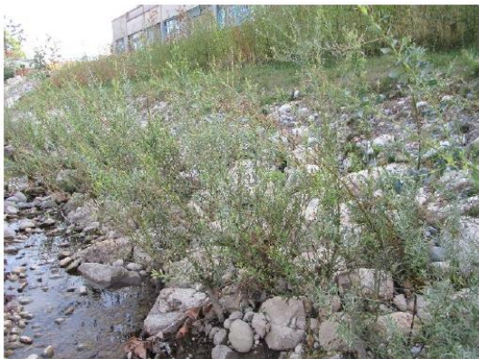
Figure 43 - Bouturage dans les enrochements à N+2 (à gauche : rive gauche aval pont des Allobroges, à droite : rive gauche amont pont CD16)
