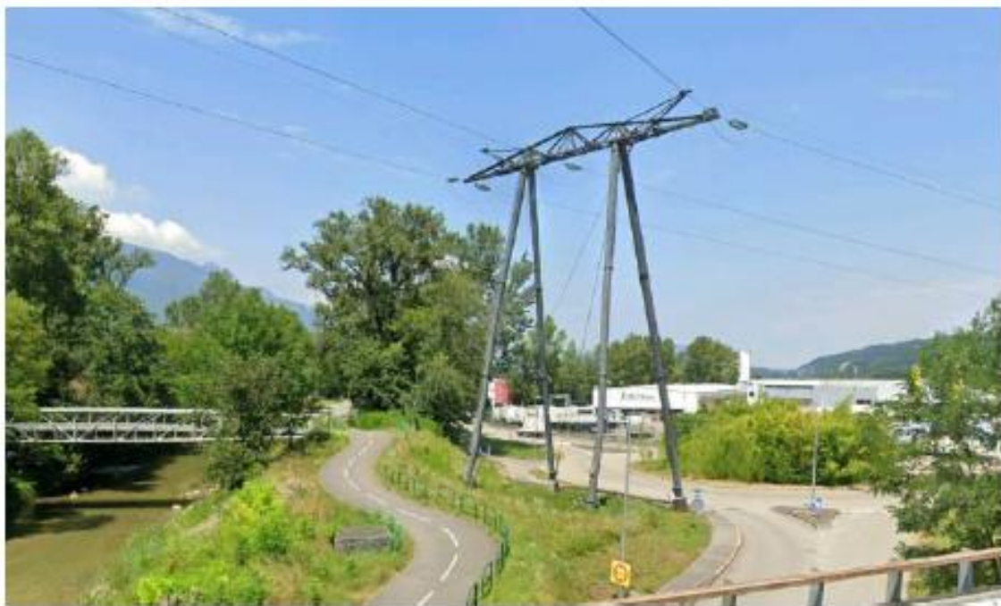
Figure 17 - Pylône de la ligne HT à l'aval immédiat du pont de l'autoroute
