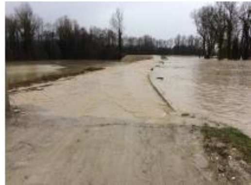
Figure 9: Déversoir de Pré-Marquis. A droite : début de surverse lors de la crue de Janvier 2018.
