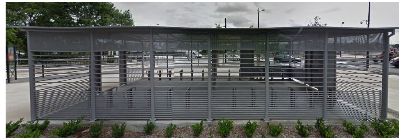
Figure 33 – Exemple de mise en œuvre à Nantes : station Ranzay route de Saint Joseph
