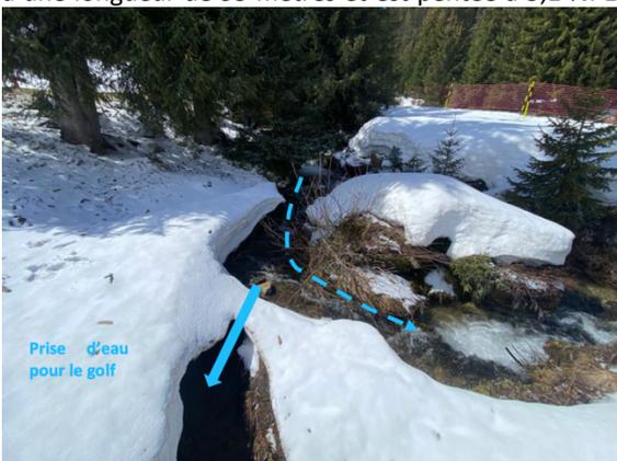
Le torrent ressort à l'air libre au niveau de la prise d'eau d'alimentation du lac du Biolley sur une dizaine de mètres. Il est ensuite à nouveau busé par une canalisation en béton, sur une longueur de 99 m, pentée à 6,3 %, et restituant dans le lit naturel situé au pied de la digue formant la retenue du Biolley. La restitution s'effectue à proximité du déversoir du lac et restitution du trop-plein de ce dernier.
