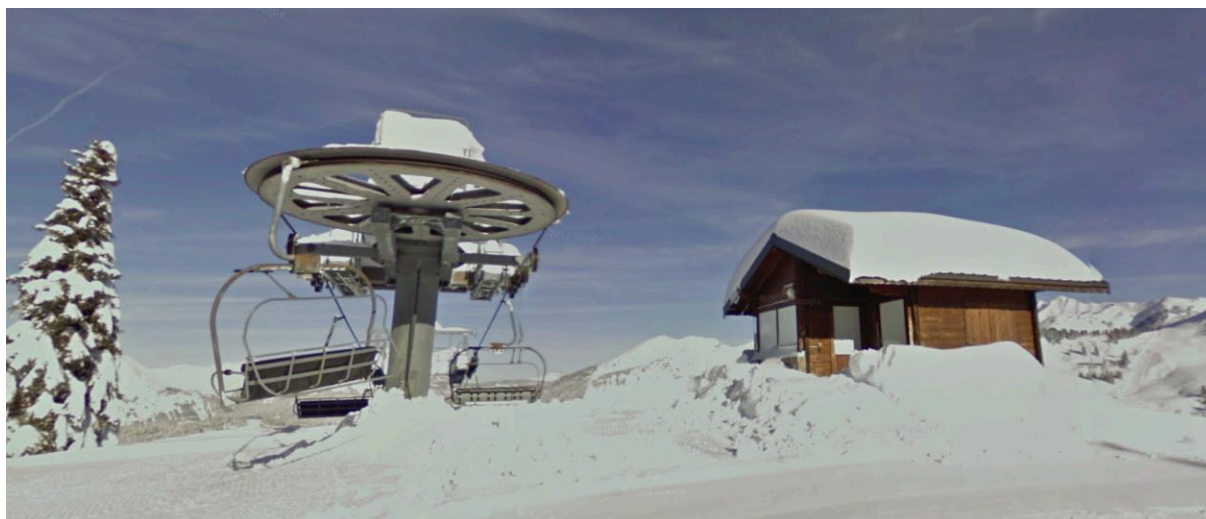
Photo en situation de la gare G2, surface de 28 m²
