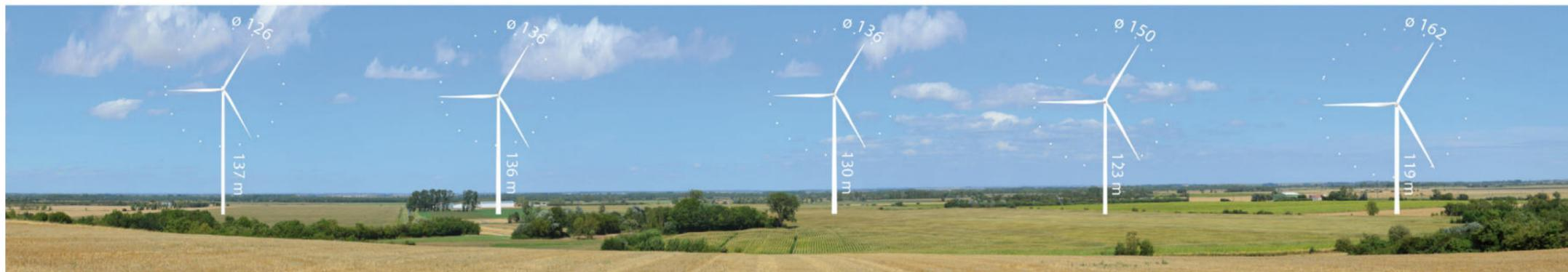
Figure 25 : Exemple du rapport de proportion entre le diamètre du rotor et la hauteur de mât (éoliennes de 200 m en bout de pale). Source : ENCIS Environnement.
