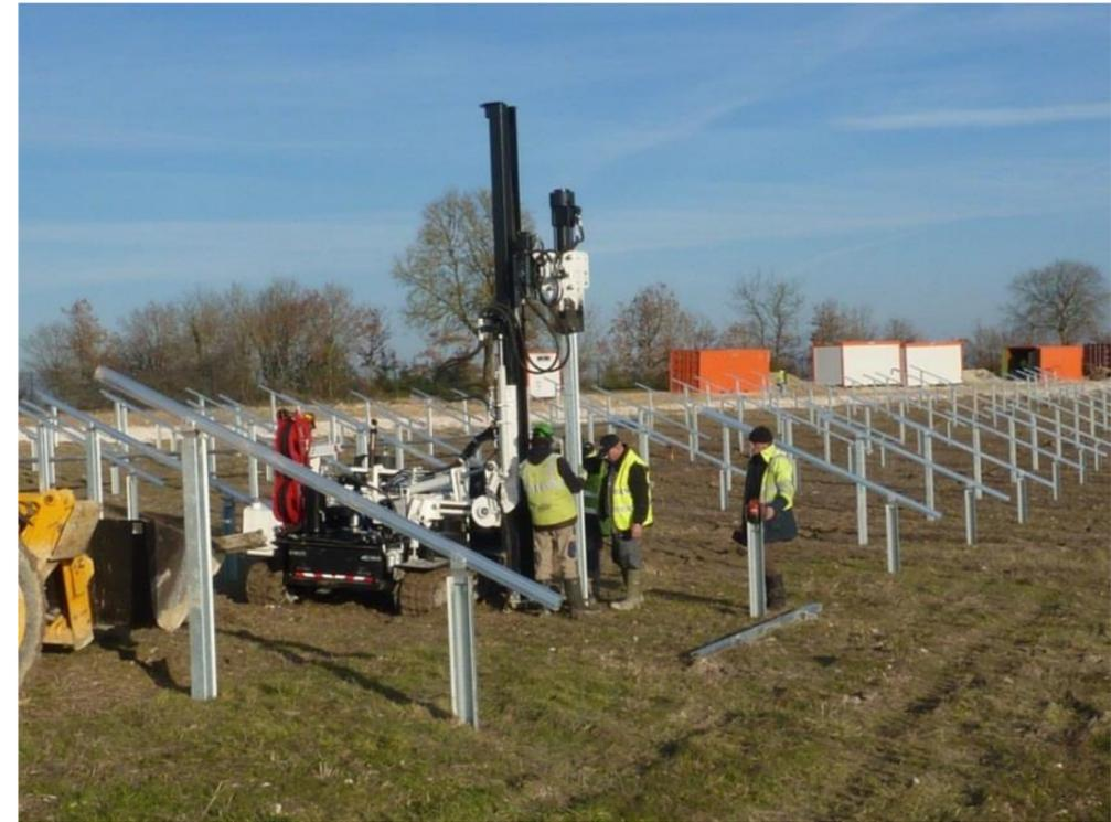
Figure 3 : Mise en place de support de panneaux
