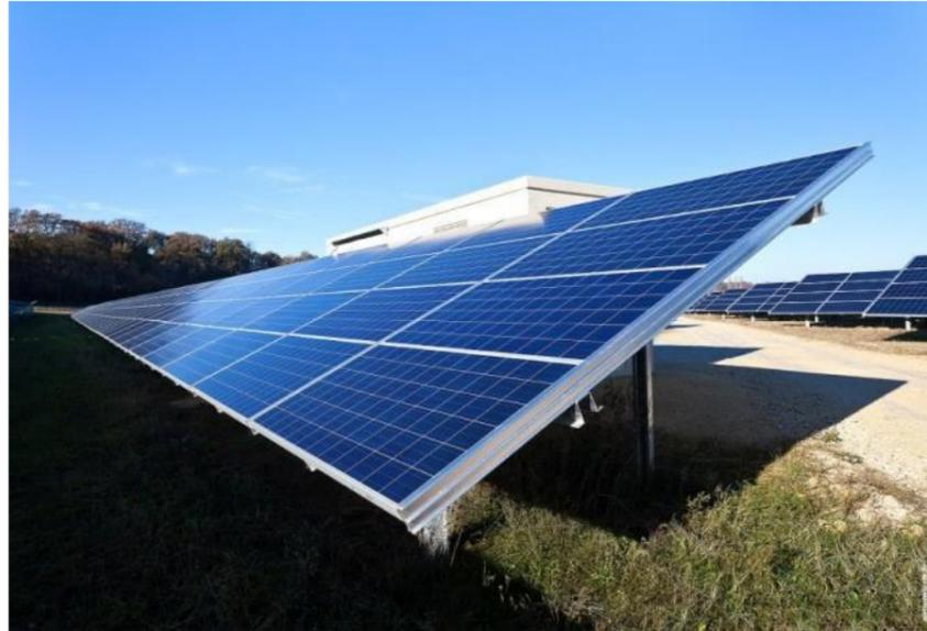
Figure 13 : Photographie d'une table modulaire
