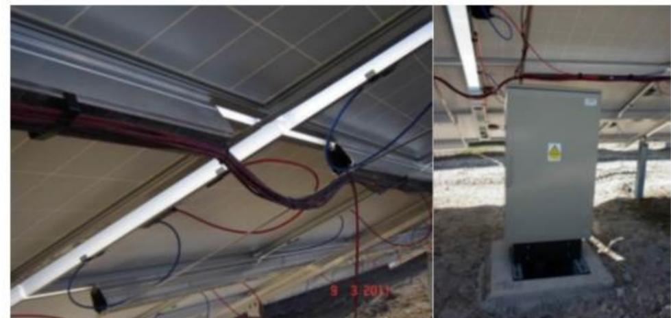
Figure 4 : Illustration du raccordement et d'une boîte de jonction « classique » ne prenant pas en compte le pâturage du site par les daims. Dans notre cas, les câbles seront soit disposés à plus de 1,50m de hauteur soit protégés dans des fourreaux ou goulottes.
