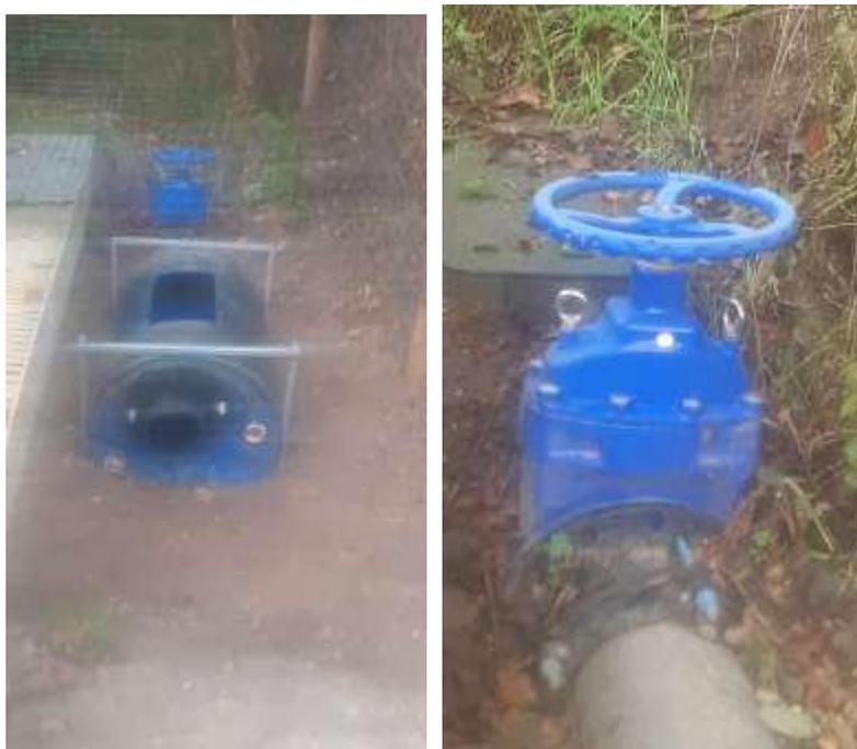
Figure 8 : Photographies du système de comptage et du trop plein
