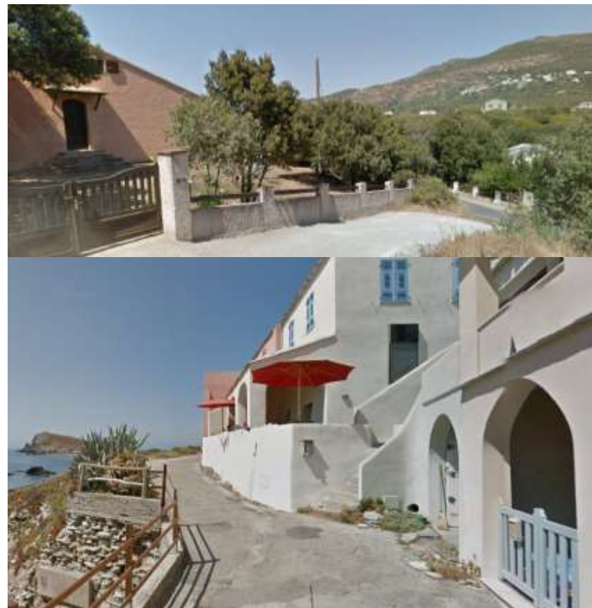
Construction traditionnelle de Mute
