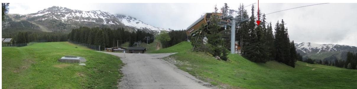
Photo 27 : Voie d'accès au dernier replat (C)
