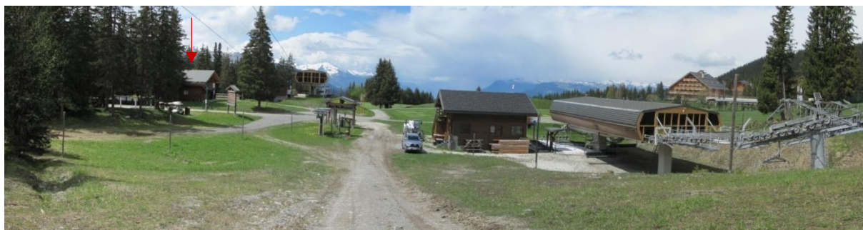
Photo 25 : Depuis l'amont – club-house, remontées mécaniques, immeuble collectif
