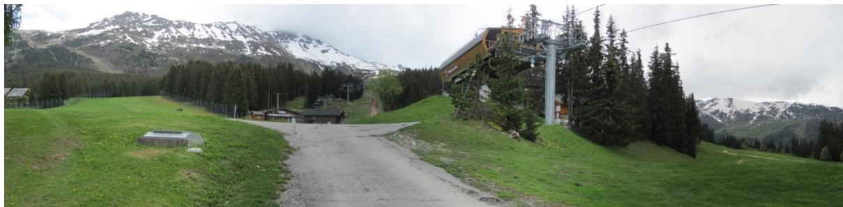
Photo 27 : Voie d'accès au dernier replat (C)
