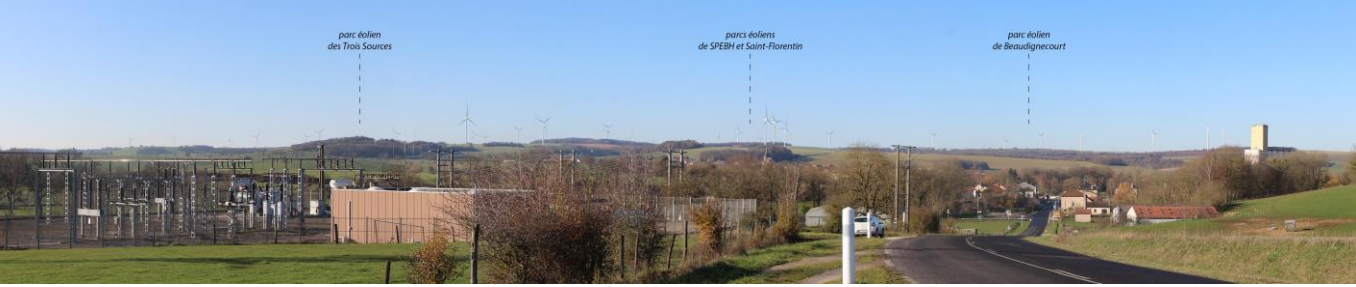
Vue C depuis la RD960 entre Delouze et Houdelaincourt
