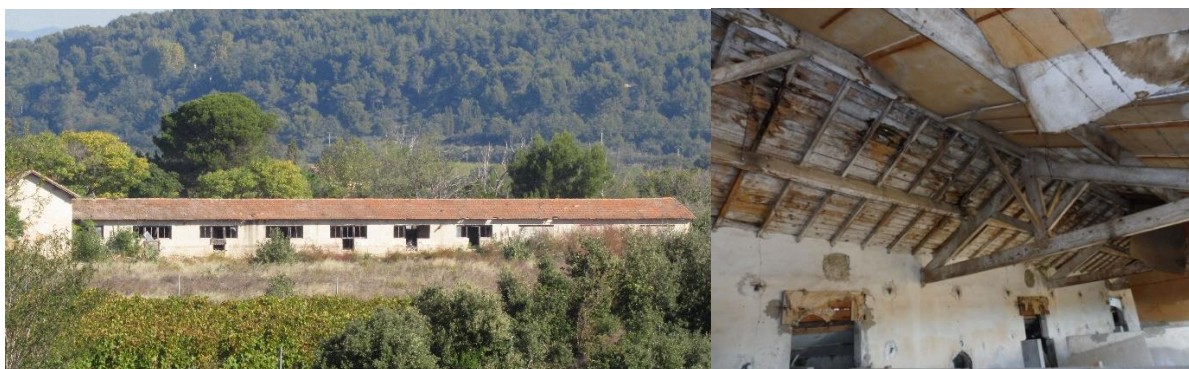
Figure 23. Photographies de l'extérieur et de l'intérieur du bâtiment abandonné au nord-ouest de l'aire d'étude (Photo sur site : L. Roussel / Naturalia 2017).
