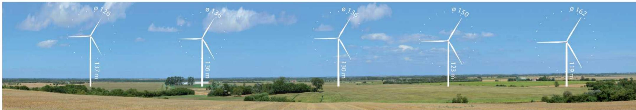
Figure 17 : Exemple du rapport de proportion entre le diamètre du rotor et la hauteur de mât (éoliennes de 200 m en bout de pale). Source : ENCIS Environnement.
