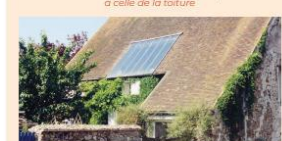
Donner l'illusion d'une verrière grâce à la taille et la disposition des capteurs
