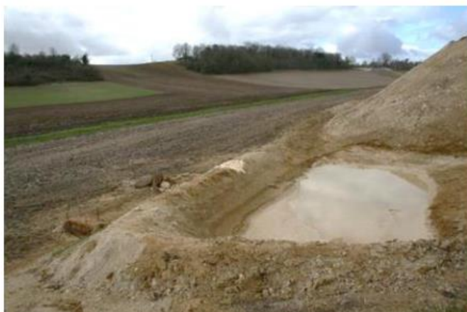
Figure 83. Bassin de décantation étanche temporaire des eaux de ruissellement en phase chantier avec filtre à paille en sortie
