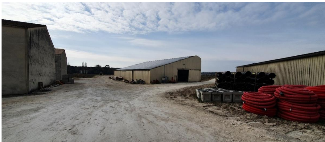
Photo 10. Chai n° 6 et 7 et hangars photovoltaïques
