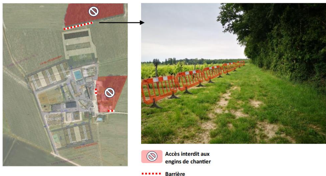
Figure 80. Evitement des milieux boisés et des espaces végétalisés adjacents par une restriction des accès aux engins de chantier
