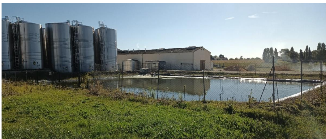
Photo 6. Cuverie vin extérieur, réserve incendie et distillerie n° 2
