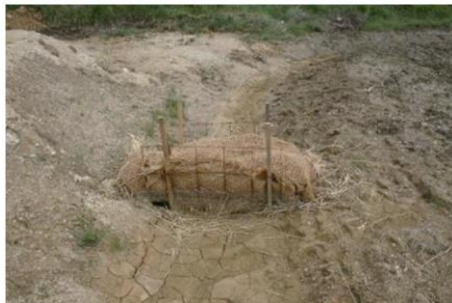
Figure 83. Bassin de décantation étanche temporaire des eaux de ruissellement en phase chantier avec filtre à paille en sortie
