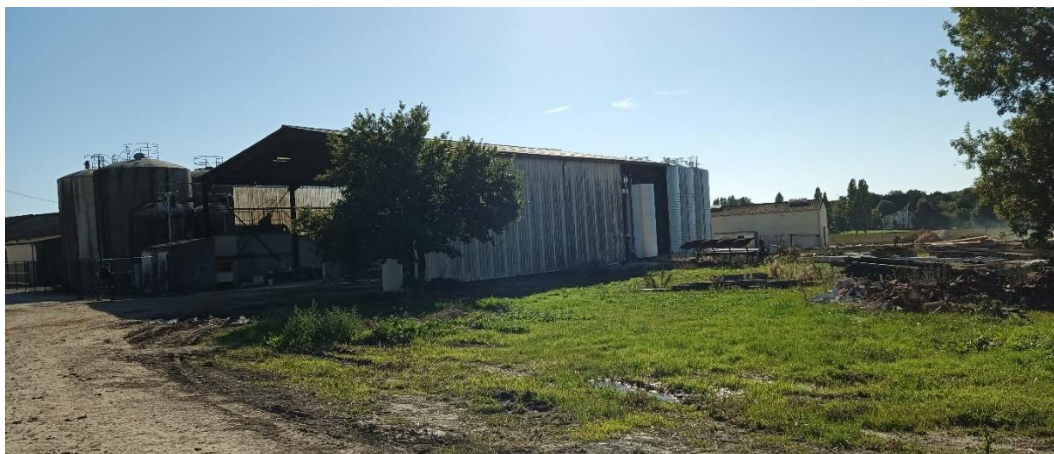
Photo 4. Ancien local pressoir
