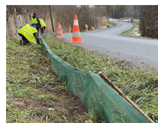
Figure 10. Filet de protection pour amphibiens (Source : LPO)
