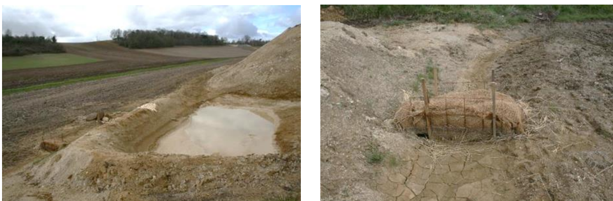
Figure 11. Bassin de décantation étanche temporaire des eaux de ruissellement en phase chantier avec filtre à paille en sortie
