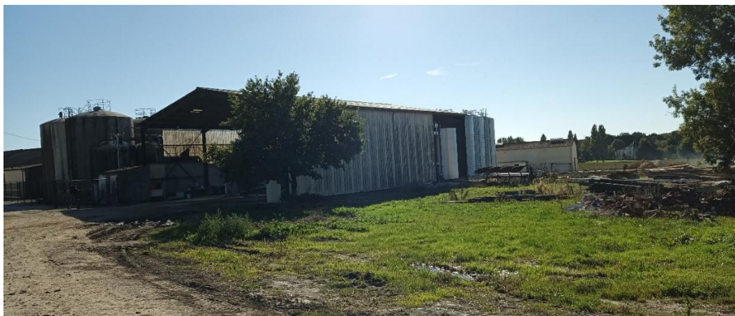
Photo 4. Ancien local pressoir
