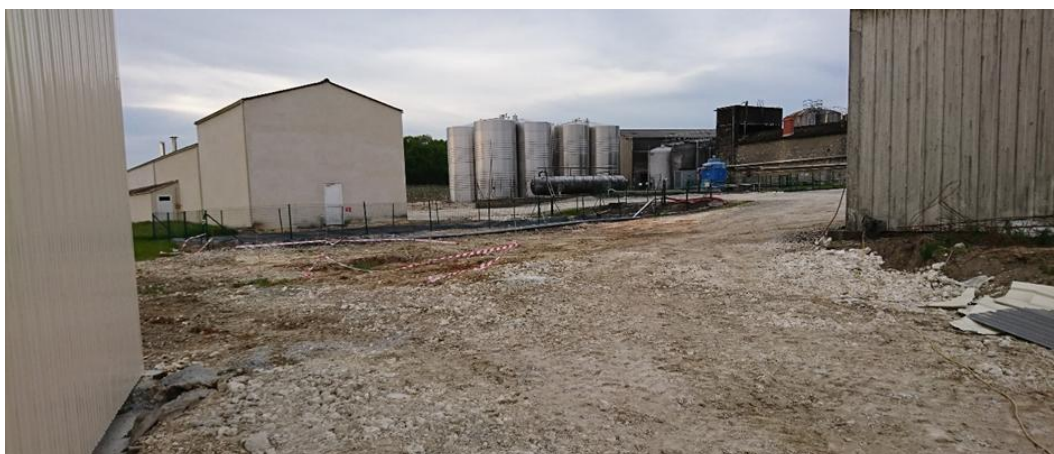
Photo 9. Bassin à vinasses, hangars, cuverie vin et distillerie n° 1
