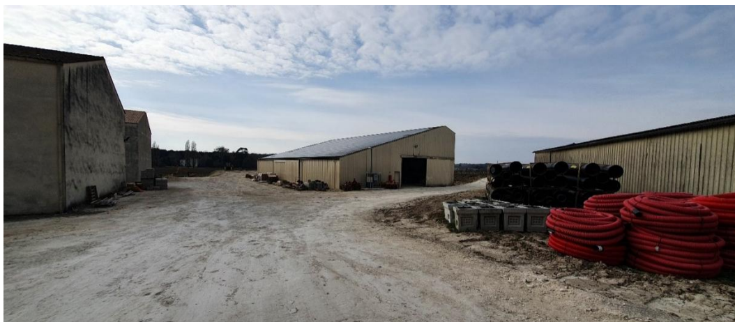
Photo 10. Chai n° 6 et 7 et hangars photovoltaïques
