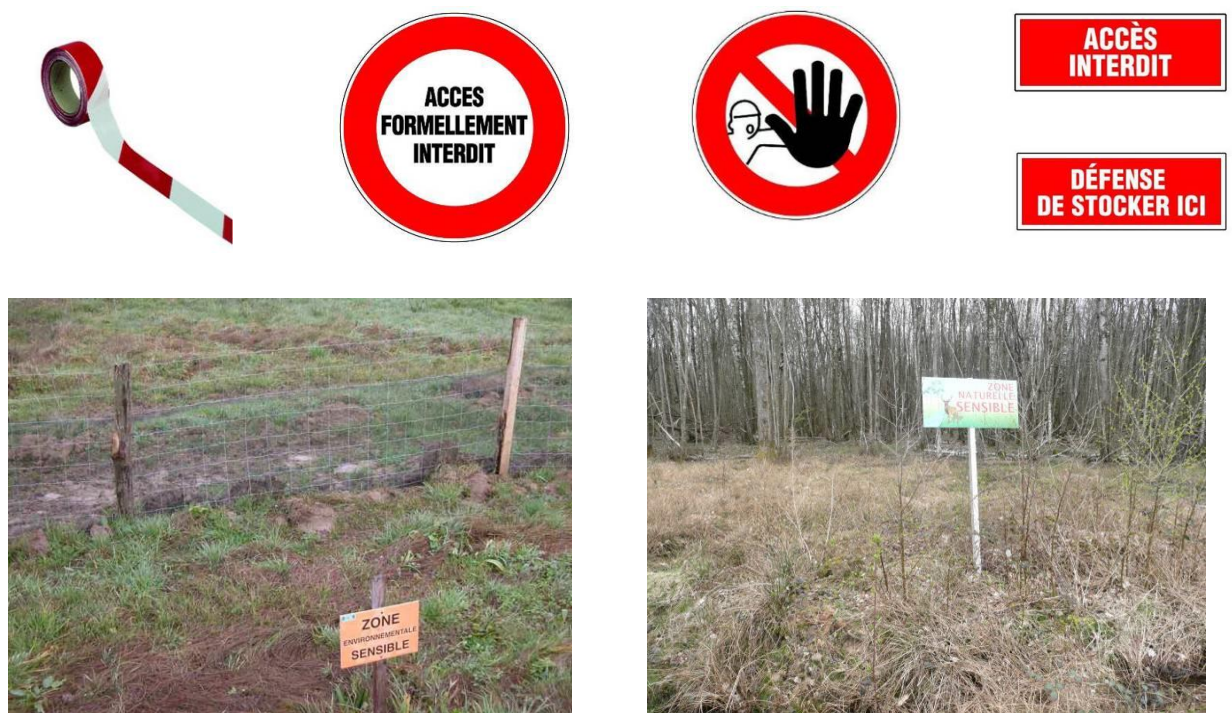
Exemple concret de panneauutage « zone environnementale sensible » sur divers chantiers
