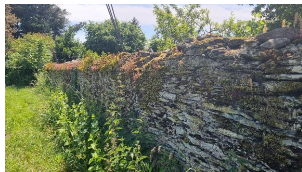
Photo 21. Mur en pierre sèche au sud du site (© Emilie Vallez)
