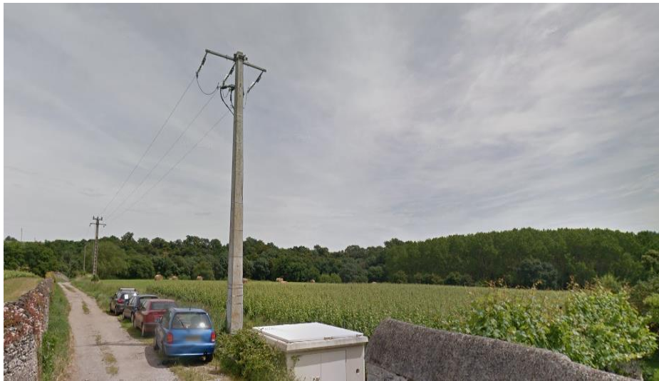
Photo 25. Ligne électrique et poste de transformation – Chemin des Perrières – Savennières
