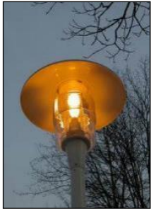
Ampoule Sodium basse pression
