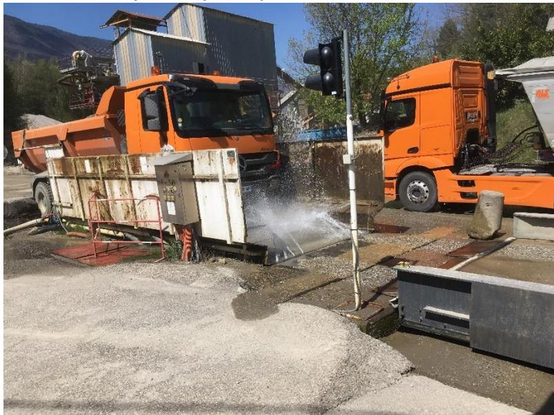
Figure 39. Lavage des véhicules pour éviter les néophytes
