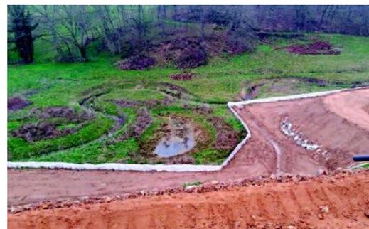
Figure 43. Clôture anti-pénétration longeant un cours d'eau - Source : AFB
