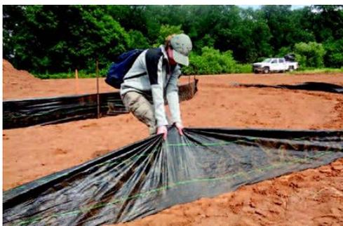
Figure 44. Ancrage au sol de la clôture anti-pénétration - Source : AFB
