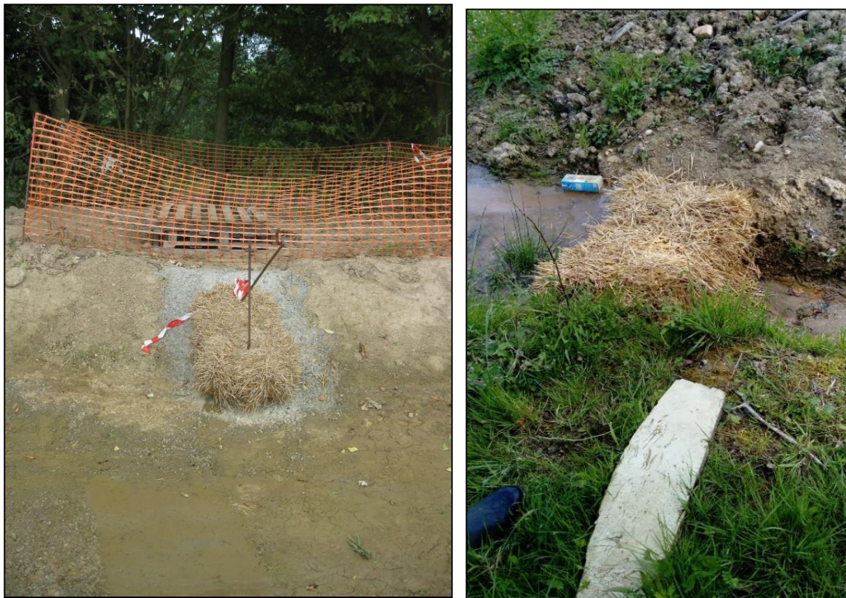
Figure 43 : Emplacements du filtre à particules fines (botte de paille) pendant la phase des travaux au niveau du bassin d'orage
