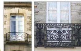
Fig. 204: Garde-corps en fer forgé
