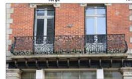
Fig. 203: Garde-corps en fer forgé
