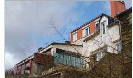
Fig. 248 : Enduit hydraulique / couleur non adaptée / menuiseries PVC
