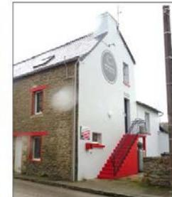
Fig. 244 : Enduit hydraulique / couleur non adaptée
