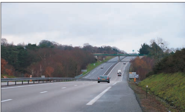
A l'Ouest, le vallon boisé limite l'impact des futures constructions
