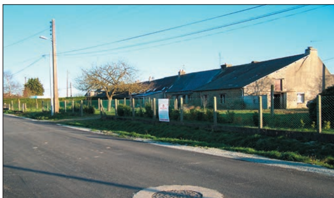
Présence d'un bâti traditionnel de qualité
