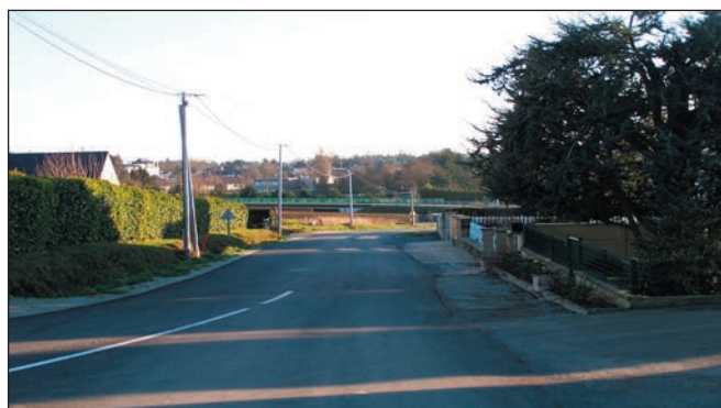
Rue des Ormeaux : un accès peu sécurisé pour le lotissement
