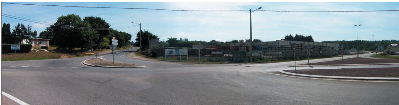
Accès à la zone d'activités de la Rochette depuis la Rd 764 et la RN 24 : un large carrefour routier
