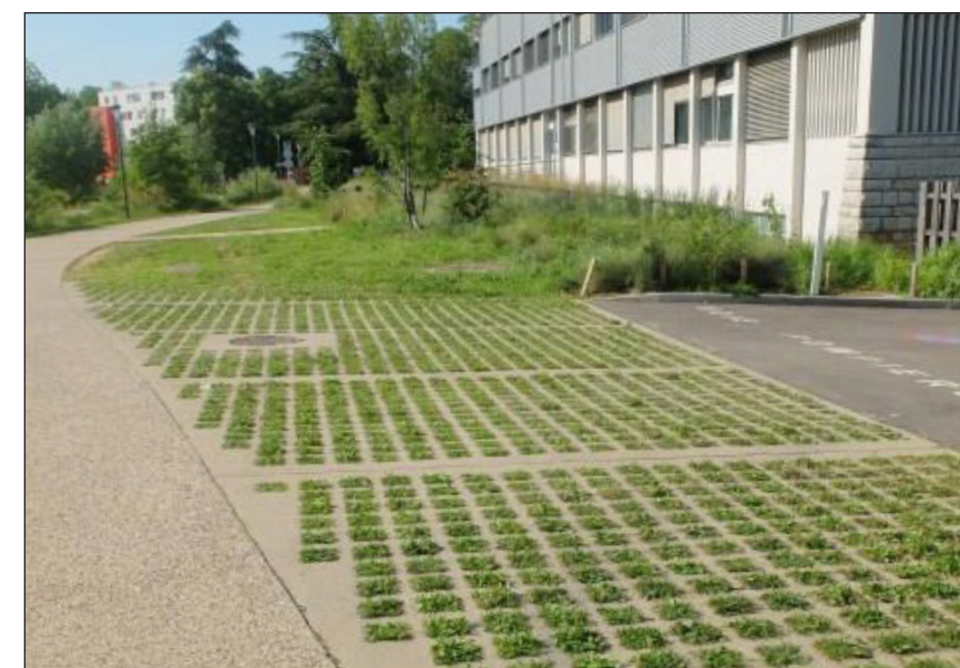
Fig. 12 : Exemples de calepinage entre espaces perméables et matériaux imperméables structurants, permettant l'infiltration des eaux de ruissellement (src. DMEAU / Yris)
