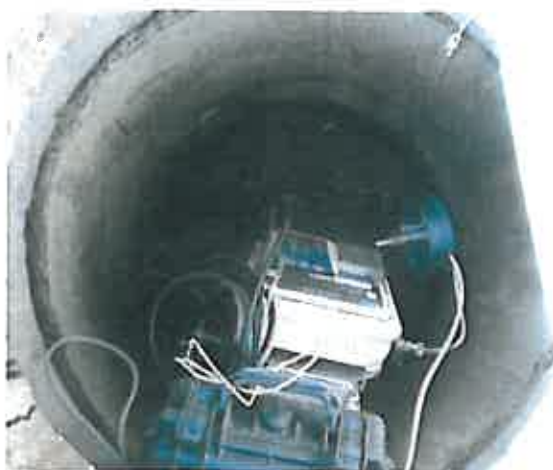
Point 45 à Vaujany
