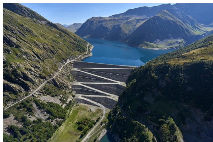
Barrage de Grand'Maison
