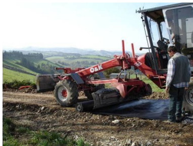
Illustration 22 : Pose du géotextile
