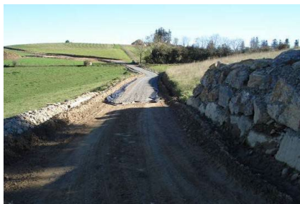
Illustration 23 : Mise en place du gravier
