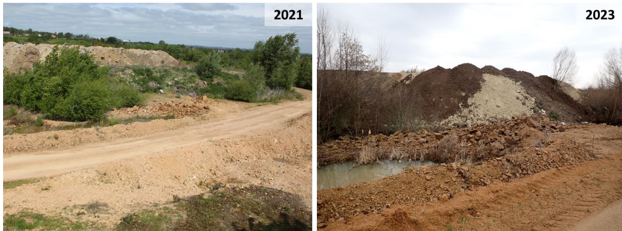
Figure 4 : Vue d'ensemble du remblaiement affectant les mares
