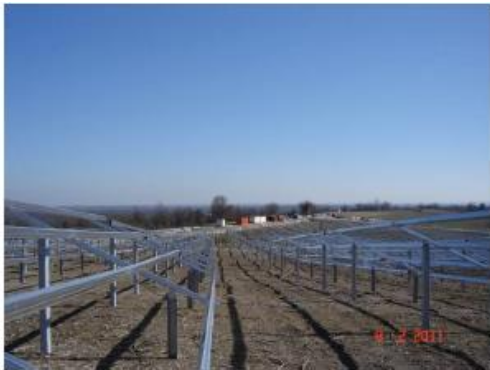
Fixation des rails de support
