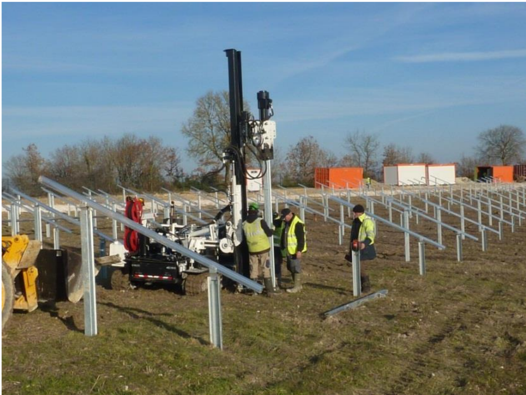
Figure 3 : Mise en place de support de panneaux
