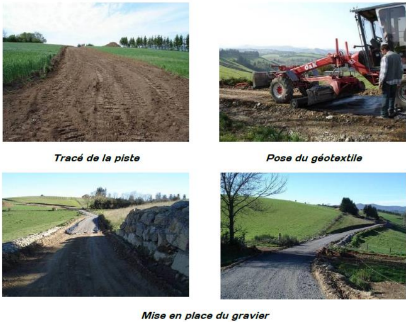
Figure 8 : Etapes de la création de pistes
