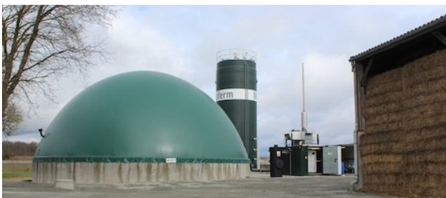
Installation de méthanisation, Saint-Lambert-La-Potherie—@bioénergieproduction
