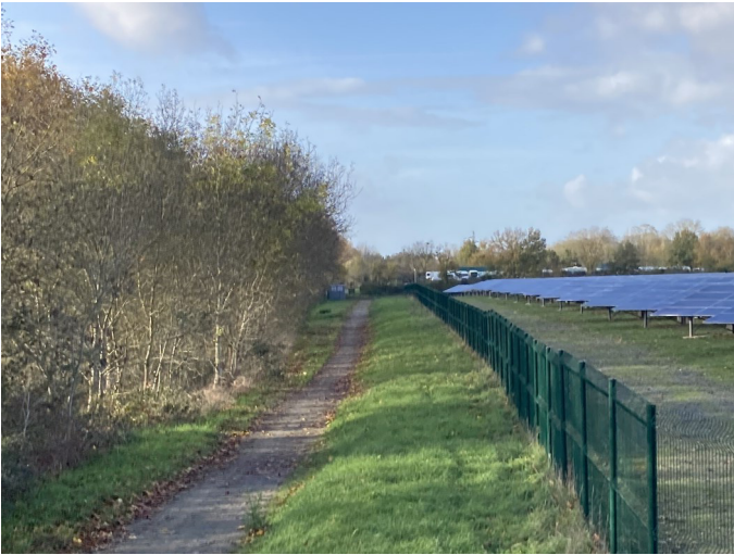
Centrale Photovoltaïque, Ponts-de-Cé —@Aura
