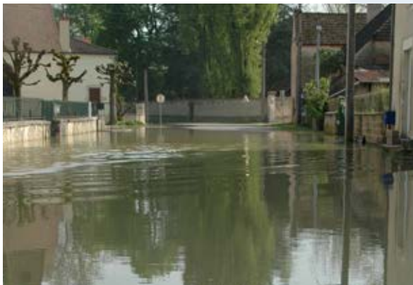
Crue de l'Ouche, commune d'Echenon - mai 2013
