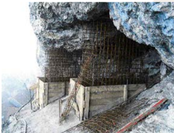
Travaux réalisés à Baubigny - ANTEA, juin 2008
