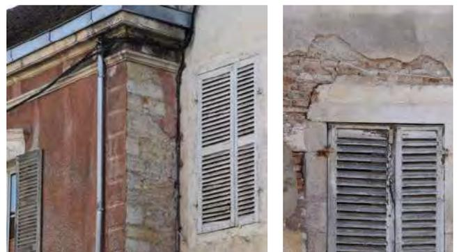
L'enduit qui se délite laisse apparaître la maçonnerie en moellons de pierre ou en brique
