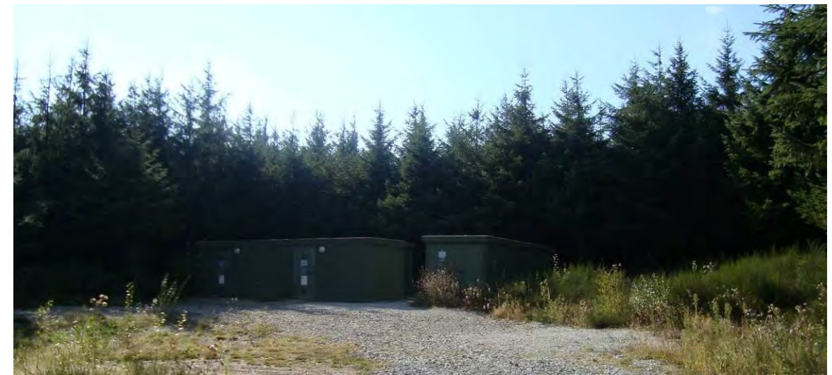
Les postes existants et leur insertion paysagères dans le contexte boisé
