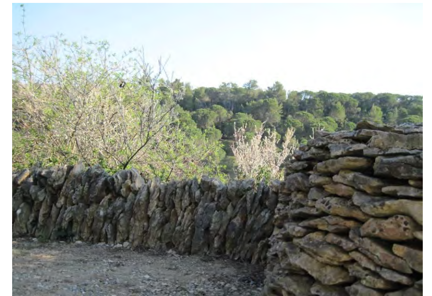
21-Muret en pierre sèche à Aragon
