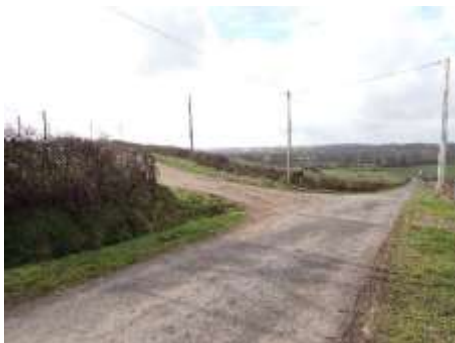
Croisement entre la route des Boussets et le chemin d'accès Source : ARTIFEX 2023
