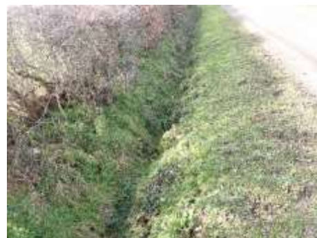
Fossés le long de la route des Boussets Source : ARTIFEX 2023
