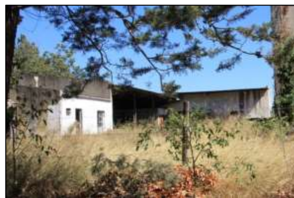
Bâtiment en ruine au lieu-dit « Enclos d'Argent »
