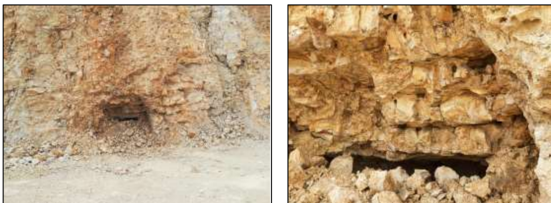
Photo 3 : Cavité et drains karstiques dans le front sud-ouest de la carrière Heidelberg Materials France Ciments
