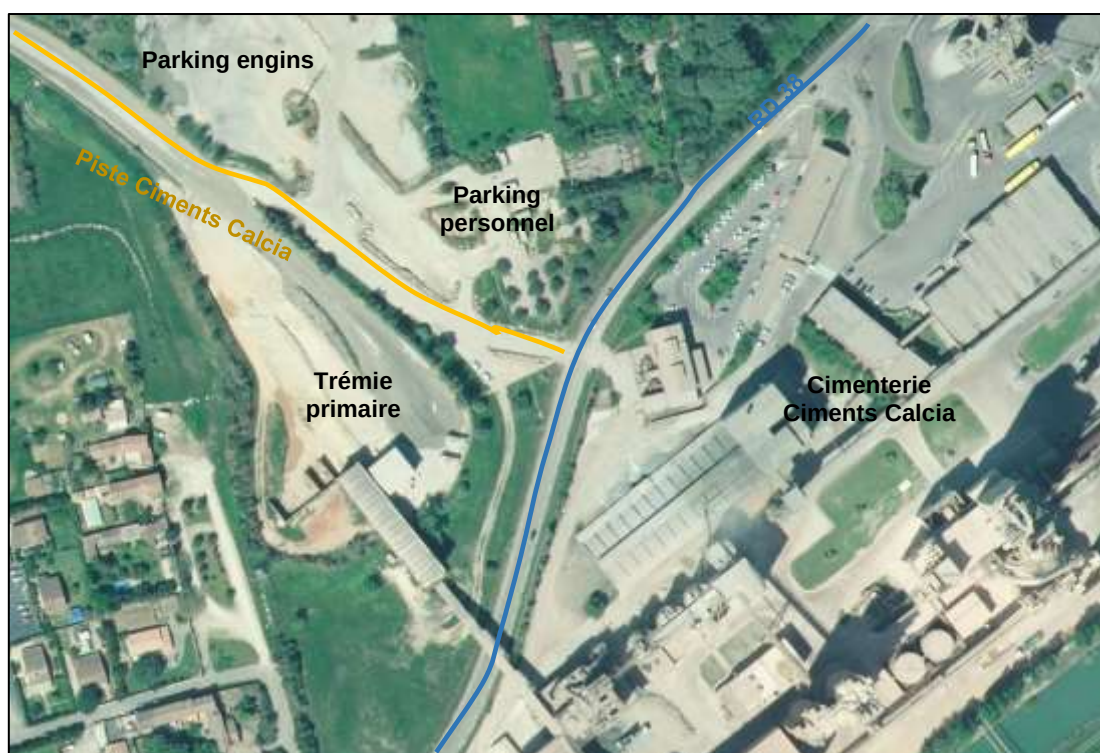
Photo 11 : Photo aérienne de l'accès à la carrière Heidelberg Materials France Ciments depuis la RD 38
