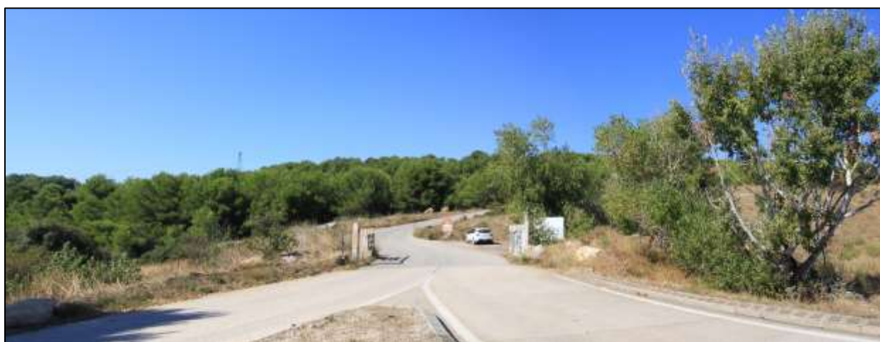
Photo 13 : Accès au site des installations GSM depuis le rond-point entre les RD 90 et 999 Source : ATDx
