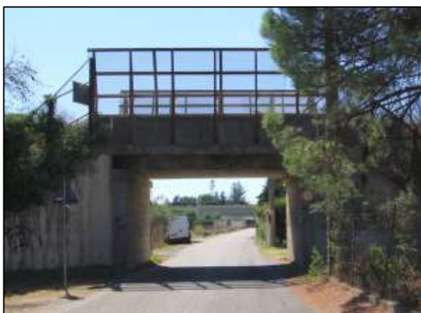
Passage sécurisé de la piste au-dessus du chemin Clapas de cornut Source : ATDx
