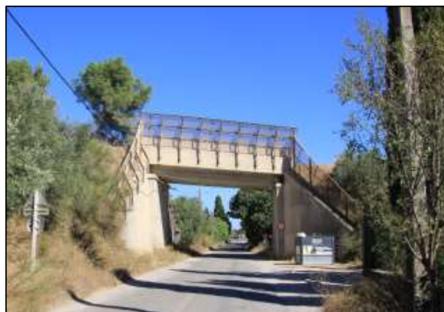
Passage sécurisé de la piste au-dessus du chemin du Roc des Mourgues Source : ATDx
