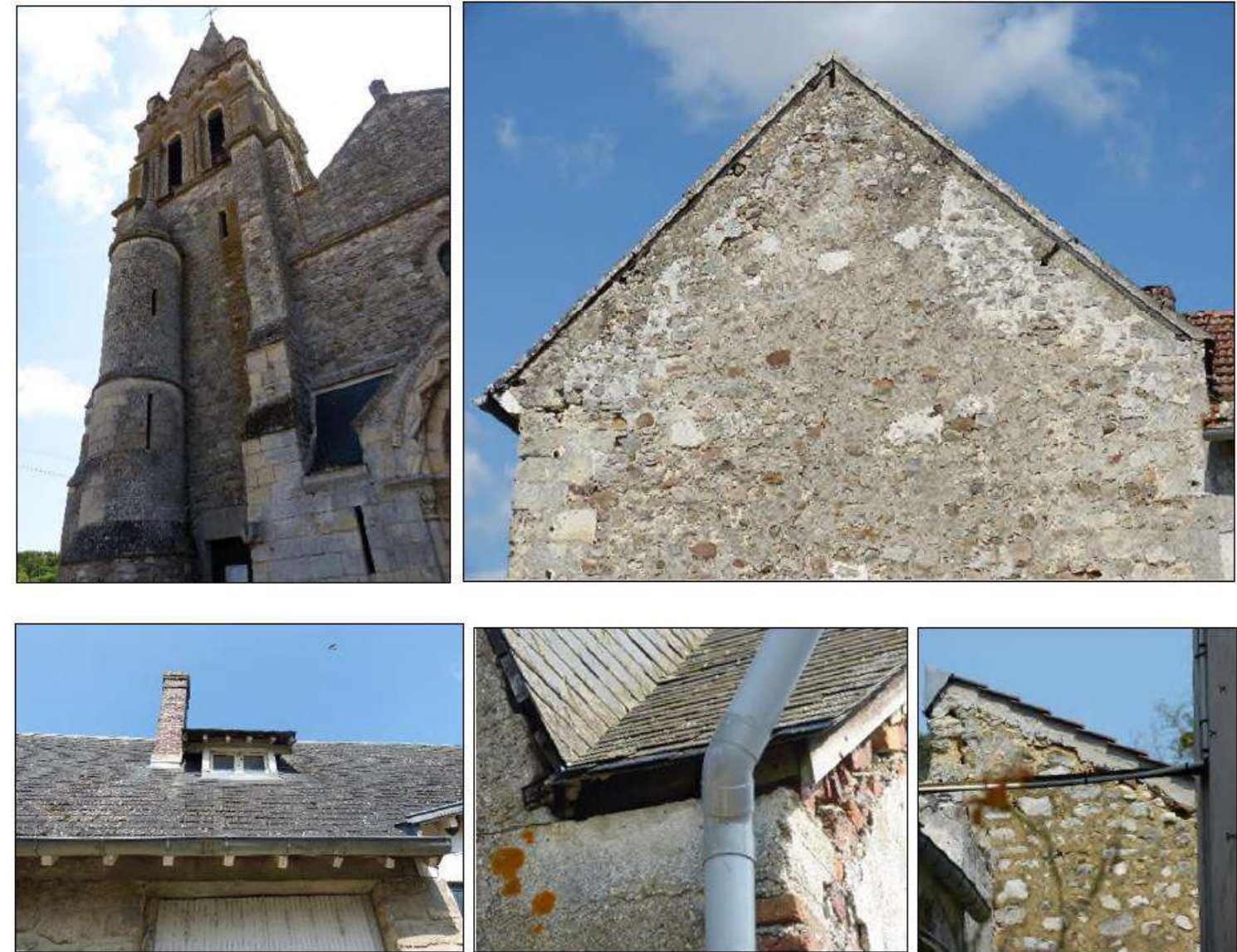
Figure 75 : Exemples de gîtes bâtis potentiels observés au sein de l'aire d'étude
