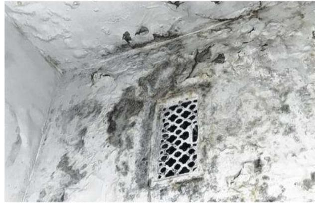
L'humidité est due au ruissellement des eaux pluviales. DR.
