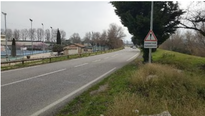
Digue coté terres – P250
