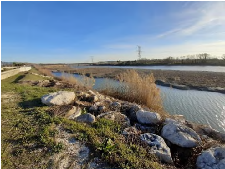
Digue coté Durance – P300
