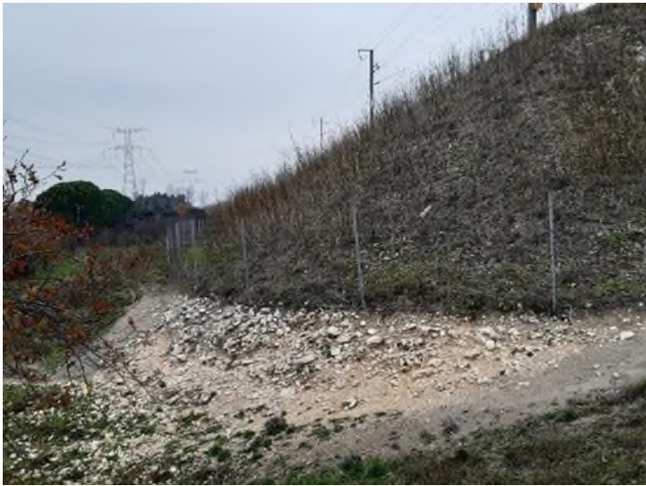
Remblai LGV coté Durance – P116
