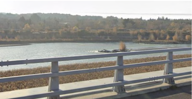
Illustration 32: Vue des digues de la Durance depuis la RD99 (Source: Google street view)
