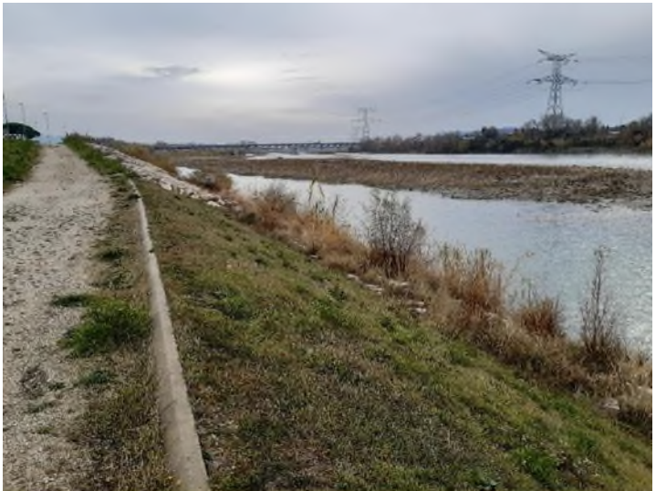
Digue coté Durance – P304
