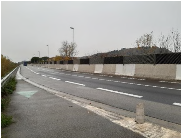
Crête digue et mur anti bruit coté terres – P281
