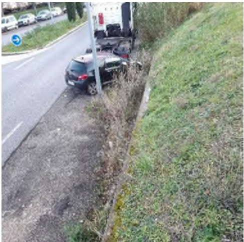
Digue coté terres – P194
