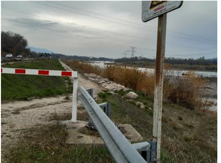
Digue coté Durance – P332
