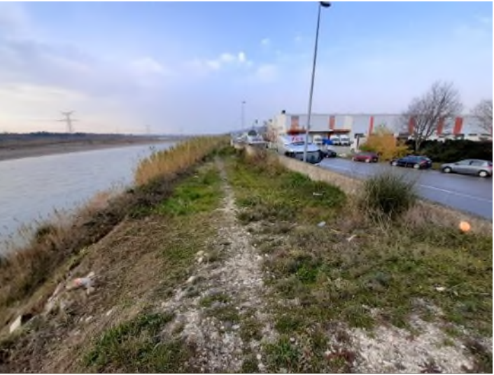
Illustration 34: Digue de la Droume depuis l'av. de la 1ère division blindée
