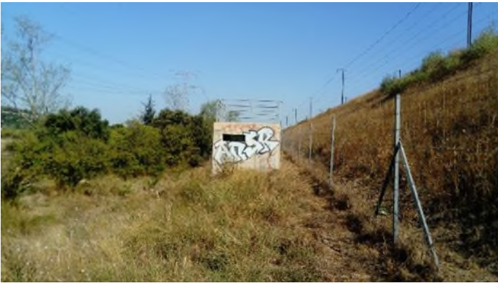
Remblai LGV coté Durance – P143
