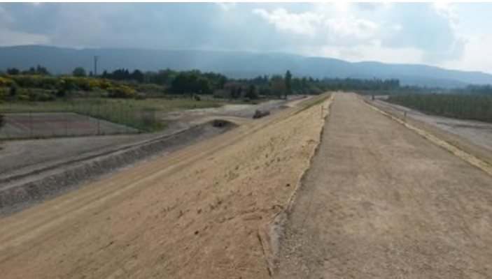
Digue coté terres – P96 en phase finale des travaux
