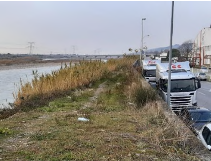
Crête de digue – P194
