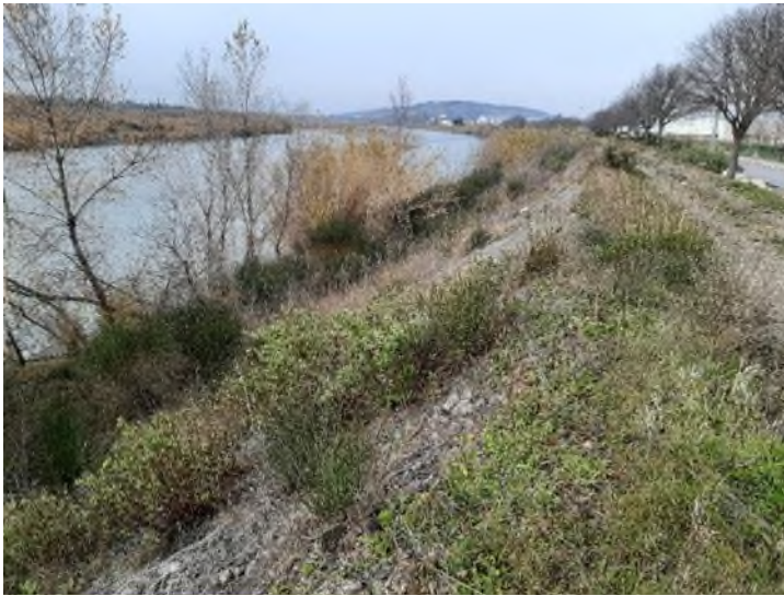
Crête de digue et talus coté Durance – P173
