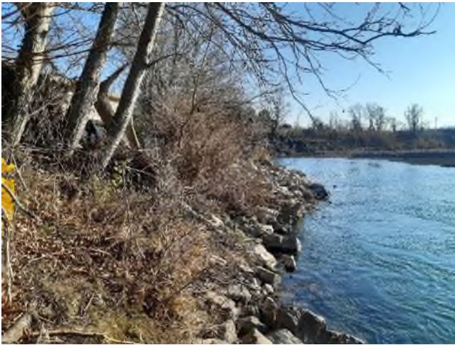
Talus digue coté Durance au droit du rejet de l’ouvrage STEP – P170
