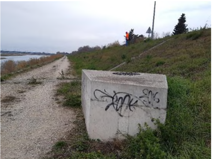
Digue coté Durance – P304
