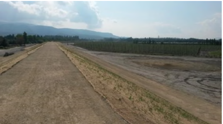
Digue coté Durance – P96 en phase finale des travaux
