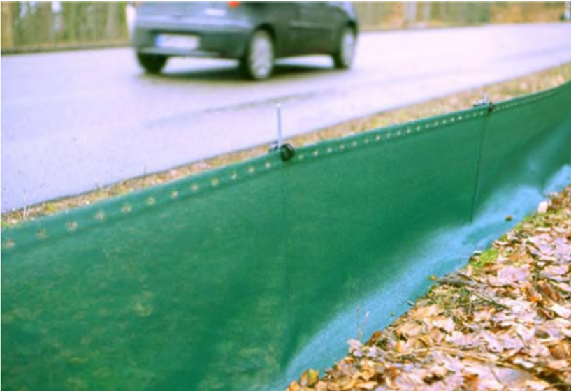
Illustration 16 : Exemple de filet anti-franchissement (Source : Schwegler)
