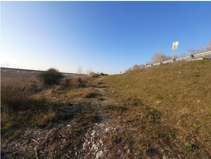
Digue coté Durance – P331
