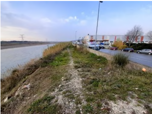
Crête de digue – P202
