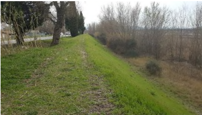
Digue coté Durance – P250
