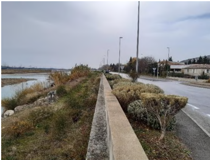
Crête digue et talus coté Durance – P293
