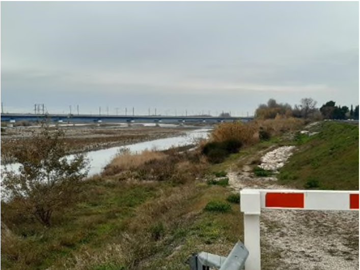
Digue coté Durance – P332
