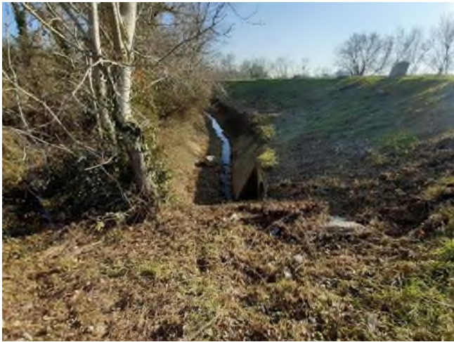
Talus digue coté terres – P170
