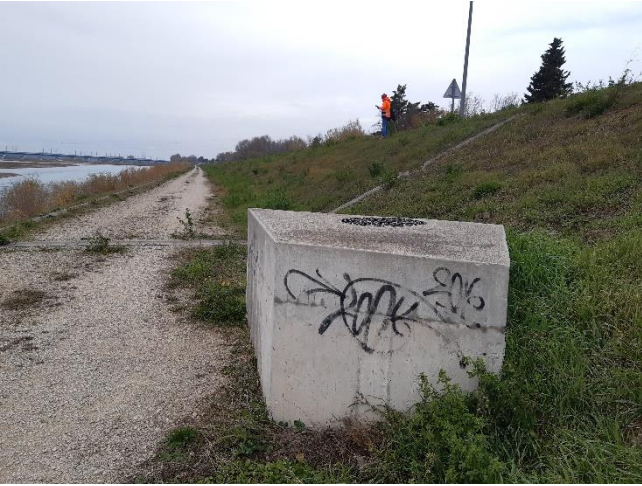
Digue coté Durance – P304
