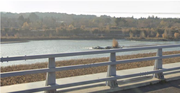
Illustration 52: Vue des digues de la Durance depuis la RD99 (Source: Google street view)
