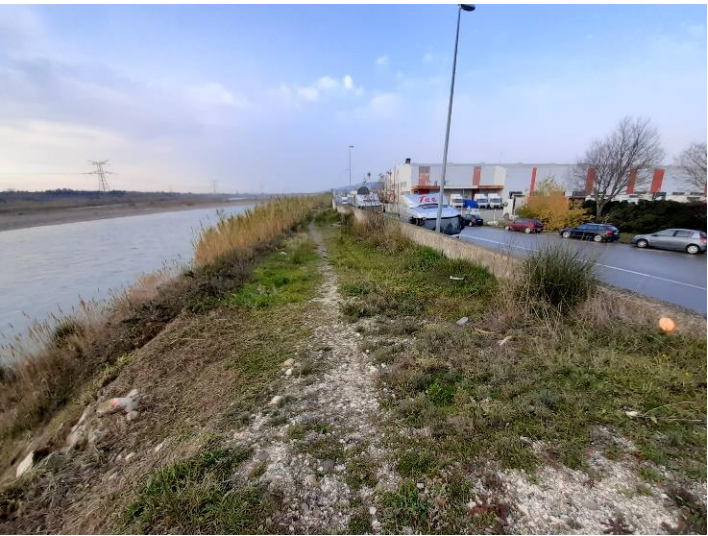
Illustration 54: Digue de la Droume depuis l'av. de la 1ère division blindée
