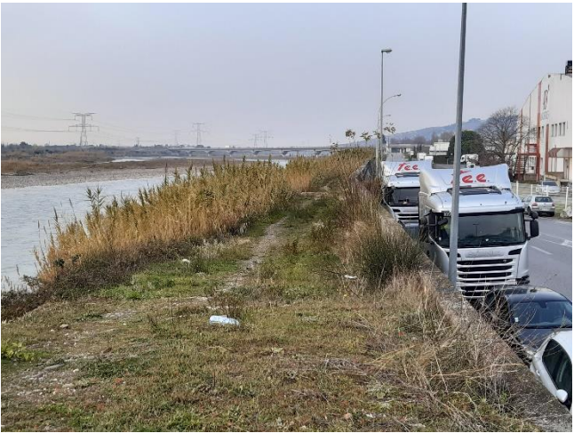
Crête de digue – P194
