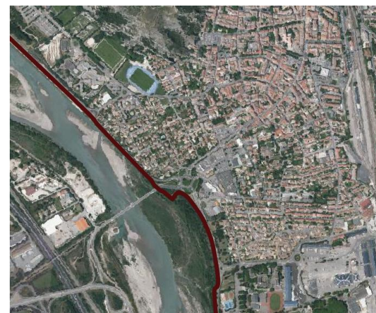
Illustration 59: Photographie aérienne des digues éparant la Durance du tissu urbain de Cavaillon
