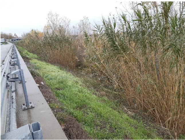
Talus digue coté Durance – P286
