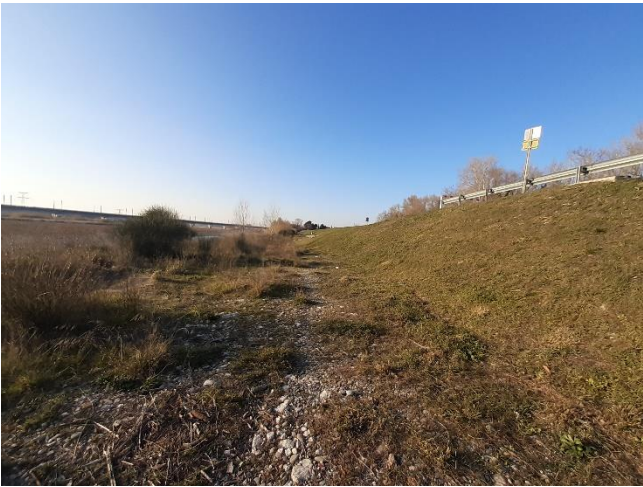
Digue coté Durance – P331
