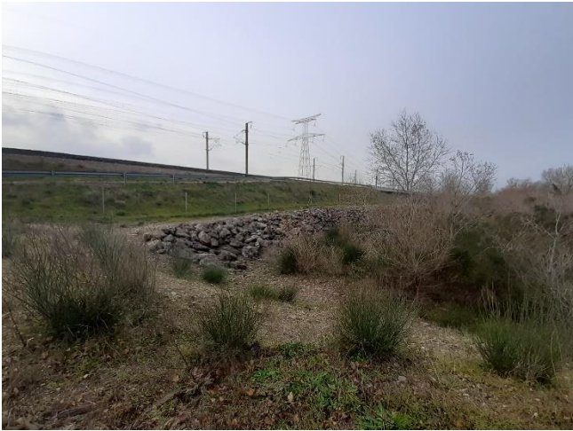
Remblai LGV coté terres – P149
