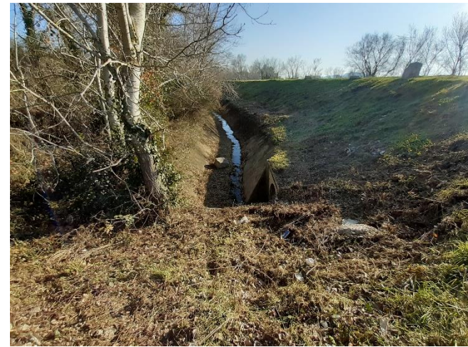
Talus digue coté terres – P170
