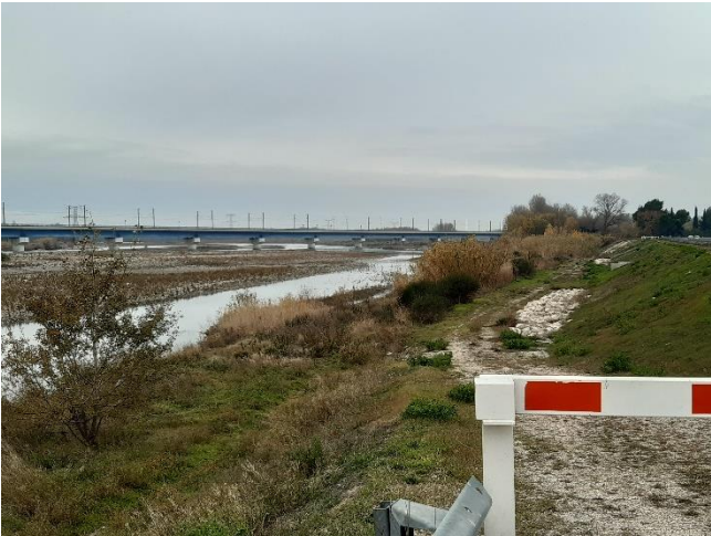
Digue coté Durance – P332
