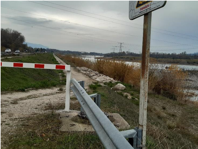
Digue coté Durance – P332
