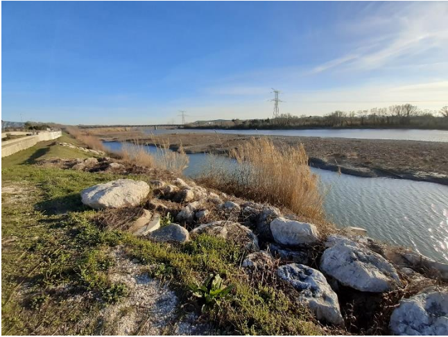
Digue coté Durance – P300
