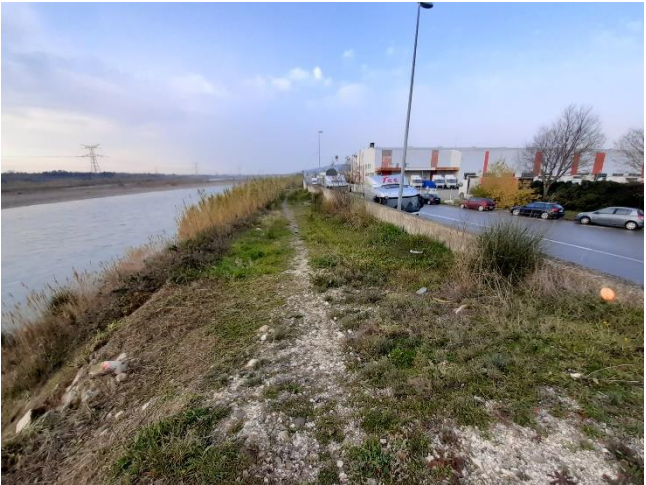
Crête de digue – P202
