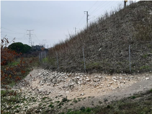
Remblai LGV coté Durance – P116
