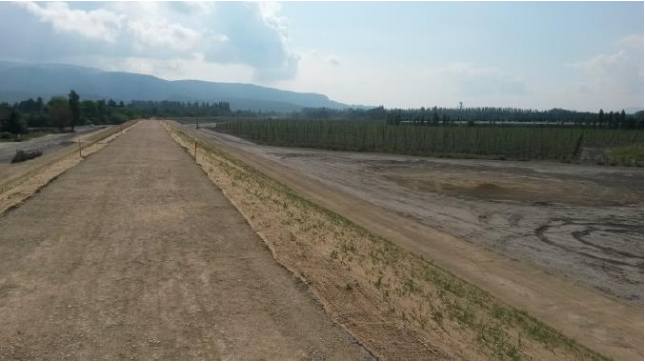
Digue coté Durance – P96 en phase finale des travaux
