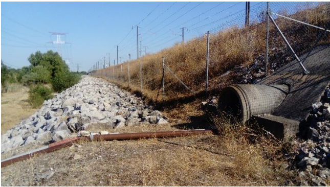
Remblai LGV coté terres – P123
