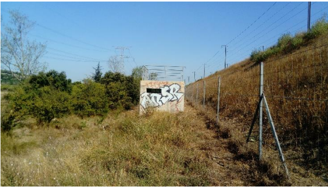
Remblai LGV coté Durance – P143
