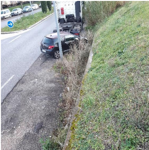
Digue coté terres – P194
