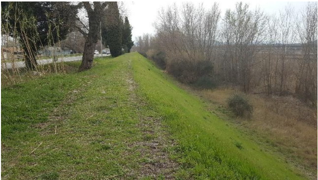
Digue coté Durance – P250
