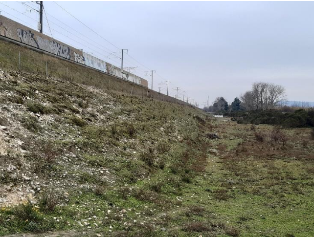
Remblai LGV coté terres – P116
