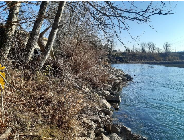
Talus digue coté Durance au droit du rejet de l’ouvrage STEP – P170
