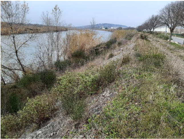
Crête de digue et talus coté Durance – P173
