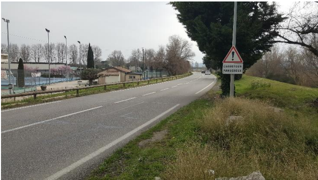
Digue coté terres – P250
