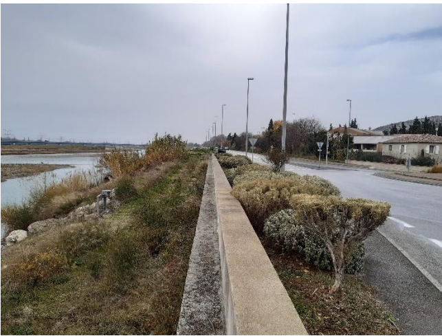
Crête digue et talus coté Durance – P293
