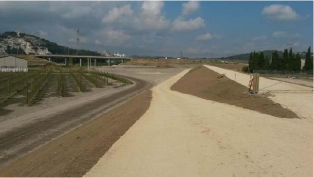
Digue coté Durance – P90 en phase finale des travaux
