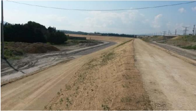
Digue coté terres – P109 en phase finale des travaux
