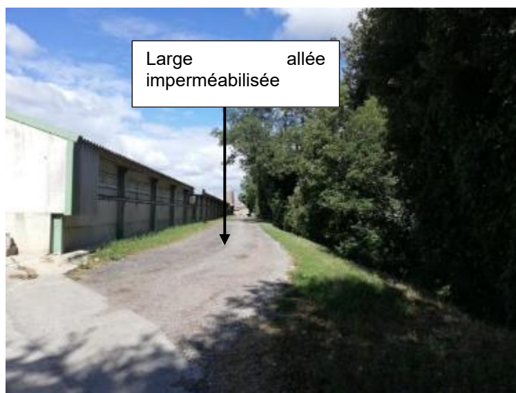
Figure 2 : Vue du passage séparant V2 de la zone boisée
