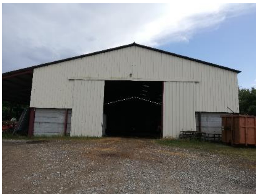
Figure 7 : Vue du hangar à paille
