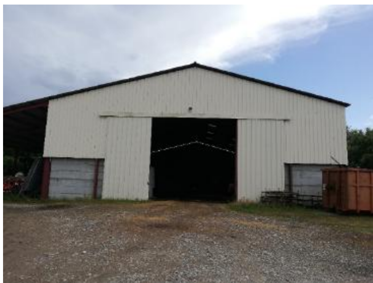
Figure 6 : Vue du hangar à paille
