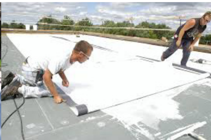
Lutte contre les îlots de chaleur Installation de membranes réfléchissantes sur les toits de Montréal © TC Media
