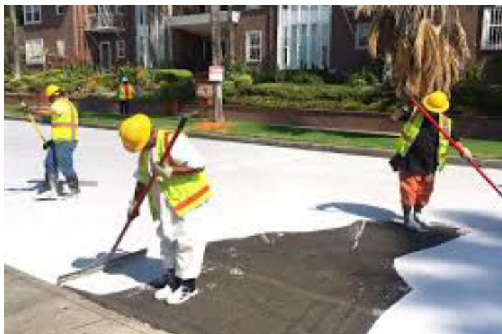
Lutte contre les îlots de chaleur Routes repeintes en blanc à Los Angeles © Le Moniteur
