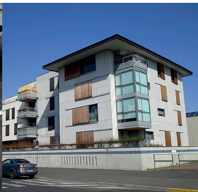
Sensibilisation au risque inondation Opération à Saint-Pierre des Corps, la ligne bleue matérialise le niveau d'eau © AJA Paul Chemetov
