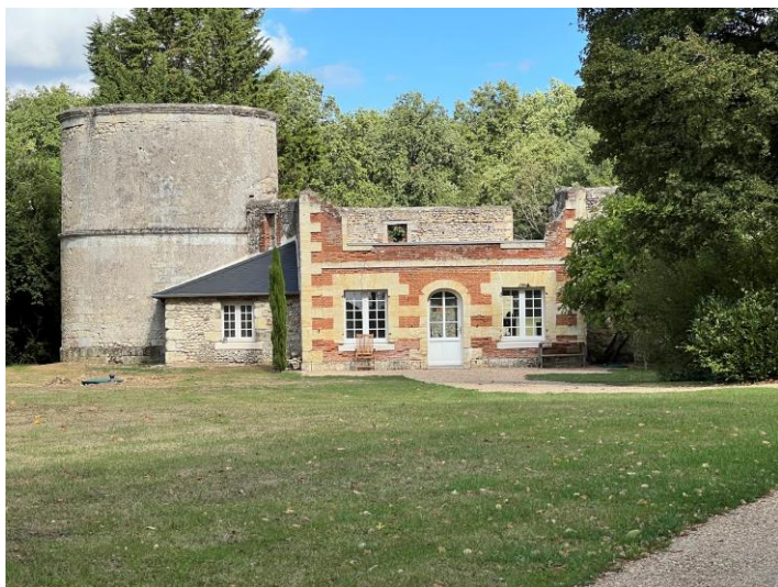
Fuye et bâtiment d'annexe
