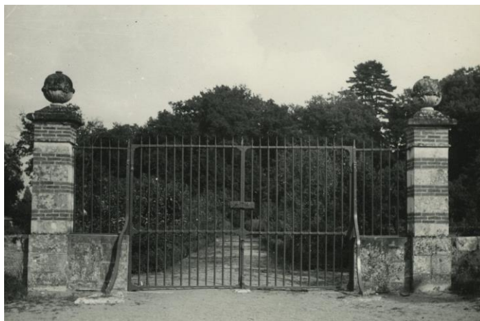
Château de Leugny : Grilles d'accès sud, vue générale Base ministère de la Culture, cote : AP15R005860
