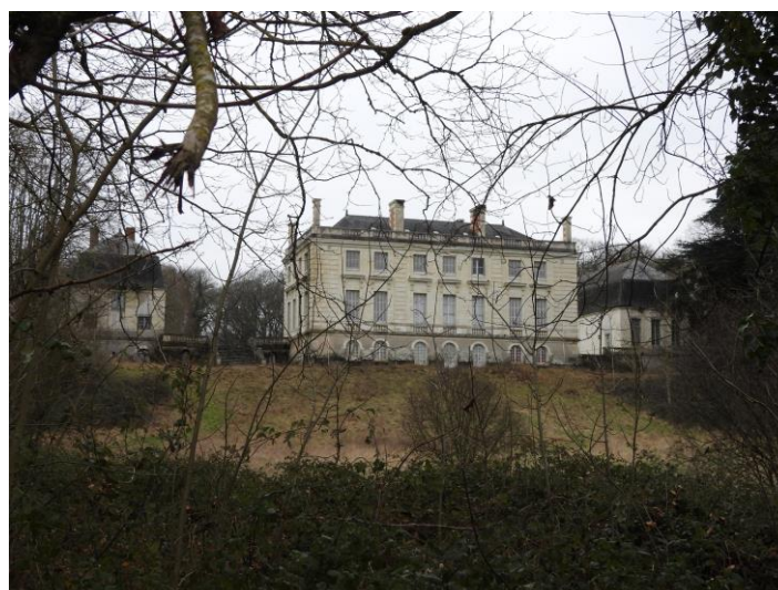
Château de Leugny et ses deux communs
