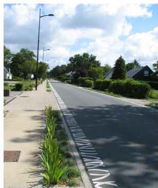
Exemple de requalification possible (CAUE 44)
