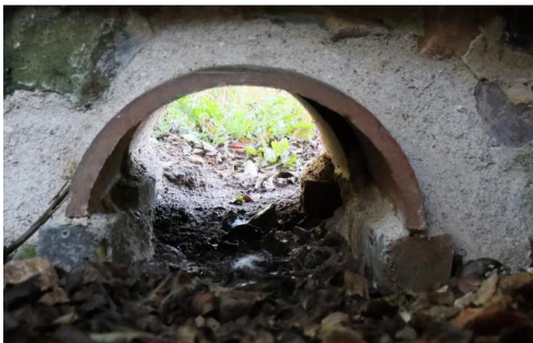
Exemples de grillage : ouvertures dans un grillage et un muret prévues pour le passage de la petite faune (Source : U2B - Limiter l'impact des clôtures sur la biodiversité, 2014)
