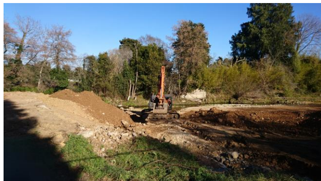
Renaturation de la Brague (Source : MTDA)
