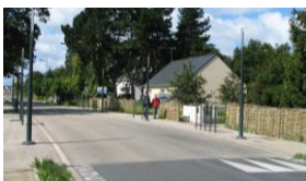
Exemple de requalification possible (CAUE 44)
