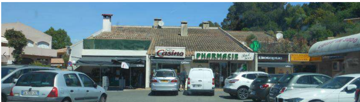
➤ Casino + Pharmacie : non conformes RNP : dépassement des limites du toit
